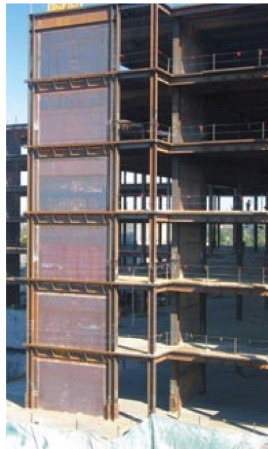
Figura 2-8. Muro ubicado en el perímetro del edificio NPCC [37].
