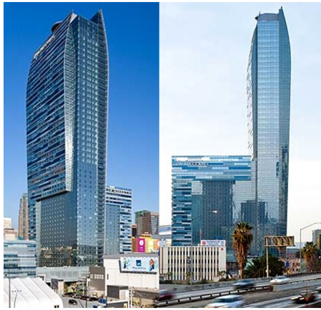
Figura 2-10. Vistas exteriores de torre LACCHC [28].
