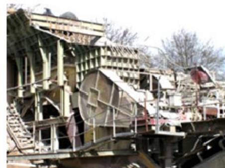
8. Carga y despacho de los materiales
