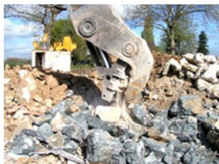
2. Tratamiento y preparación de los materiales previa a la trituración
