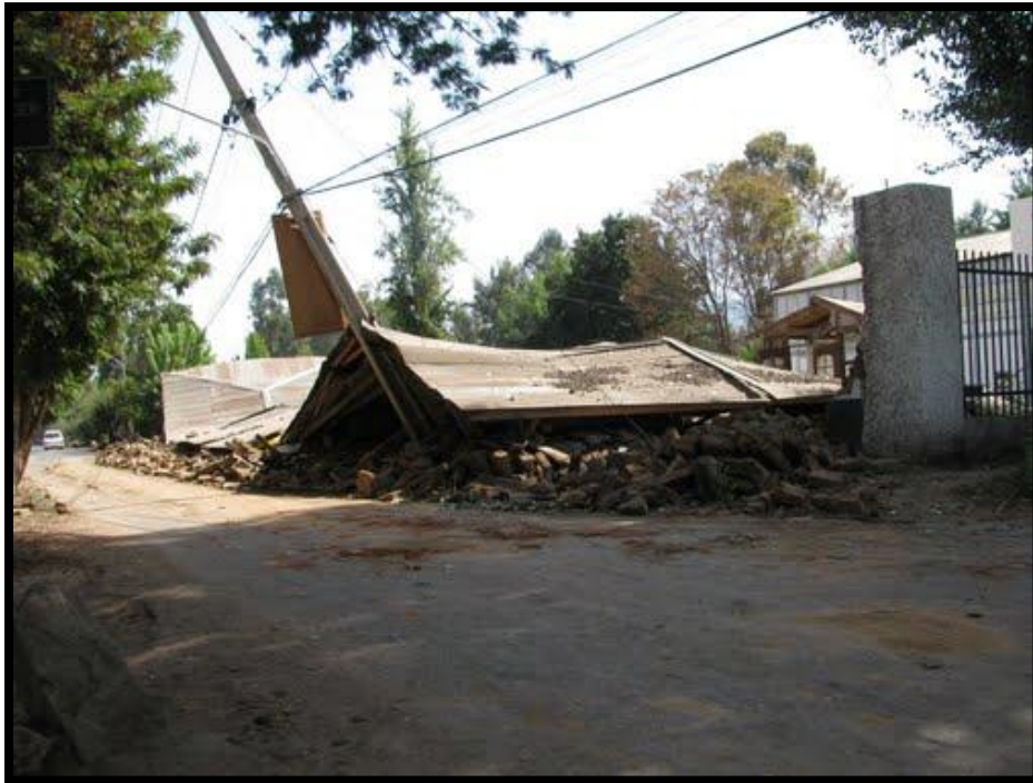
Fotografía 30. Casa en Pintué. Total destrucción debido al terremoto del 2010. (Fuente: Panoramio.com)
