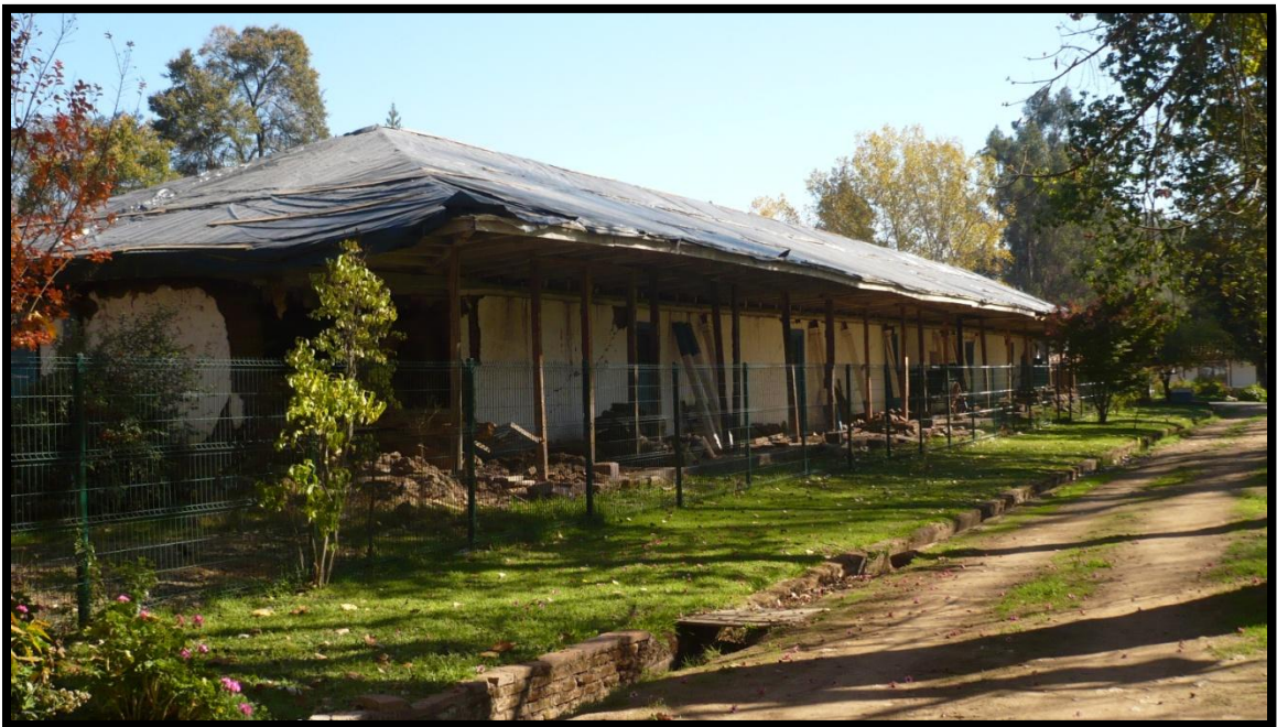
Fotografía 32. Casa patronal frente a comisaria de Carabineros en Pintué. Bastante dañadas producto del terremoto del 2010.
