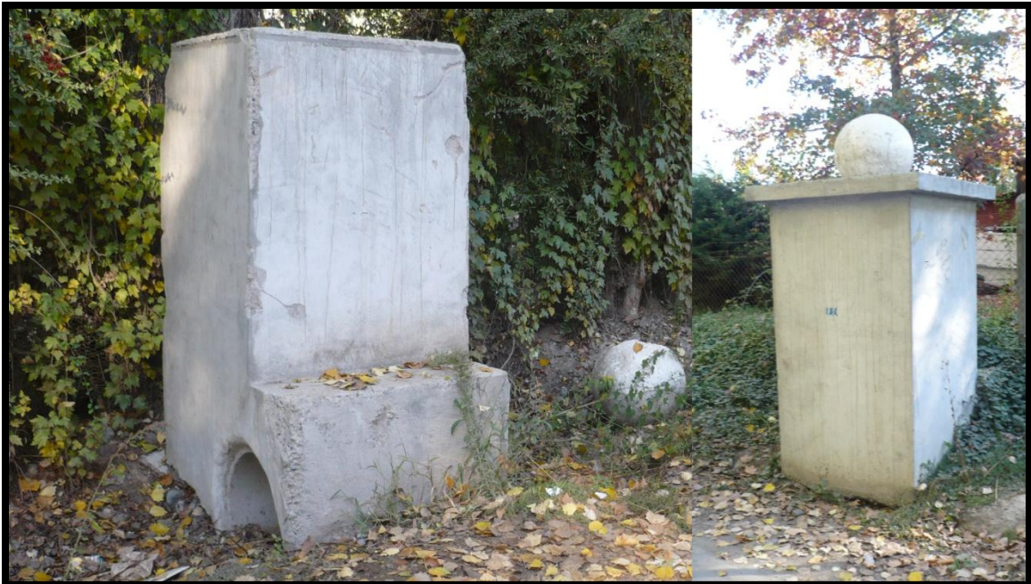
Fotografía 18. Fotografía de dos columnas de adorno de la entrada a los champiñones Abrantes. Una de las columnas quedó sin la esfera de cemento producto del terremoto del 2010.
