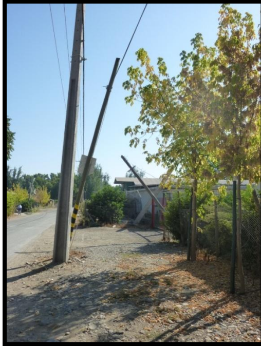
Fotografía 19. Alambrado público frente a la empresa de champiñones Abrantes, inclinados por el terremoto del 2010.
