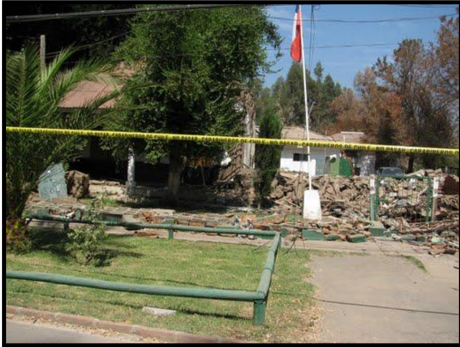
Fotografía 29. Comisaría de Carabineros de Chile en Pintué. Total destrucción debido al terremoto del 2010. (Fuente: Panoramio.com).
