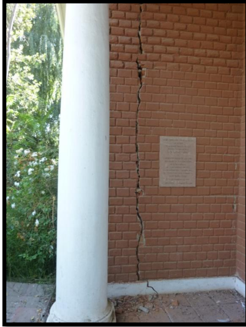
Fotografía 21. Estructura en la muralla de la capilla de Abrantes, a mayor detalle se puede observar que el nivel izquierdo descendió producto del asentamiento de la edificación. (Fotografía: Javiera González).
