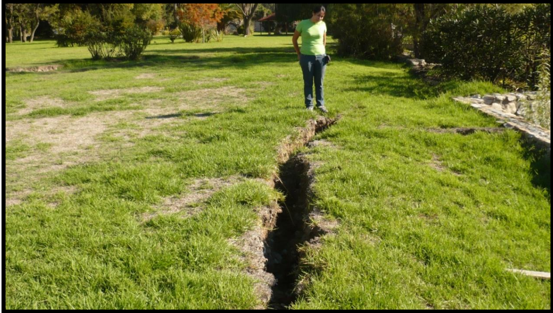
Fotografía 11. Estructura generada por el terremoto 2010 ubicada al norte de la entrada de Alto Laguna, con espaciamiento de 30 cm y profundidades de hasta 1 m, correspondiente a "lateral spreading". Fotografía orientada hacia el oeste, paralela a la orilla de la laguna, distanciada por 5 m aprox. de esta.
