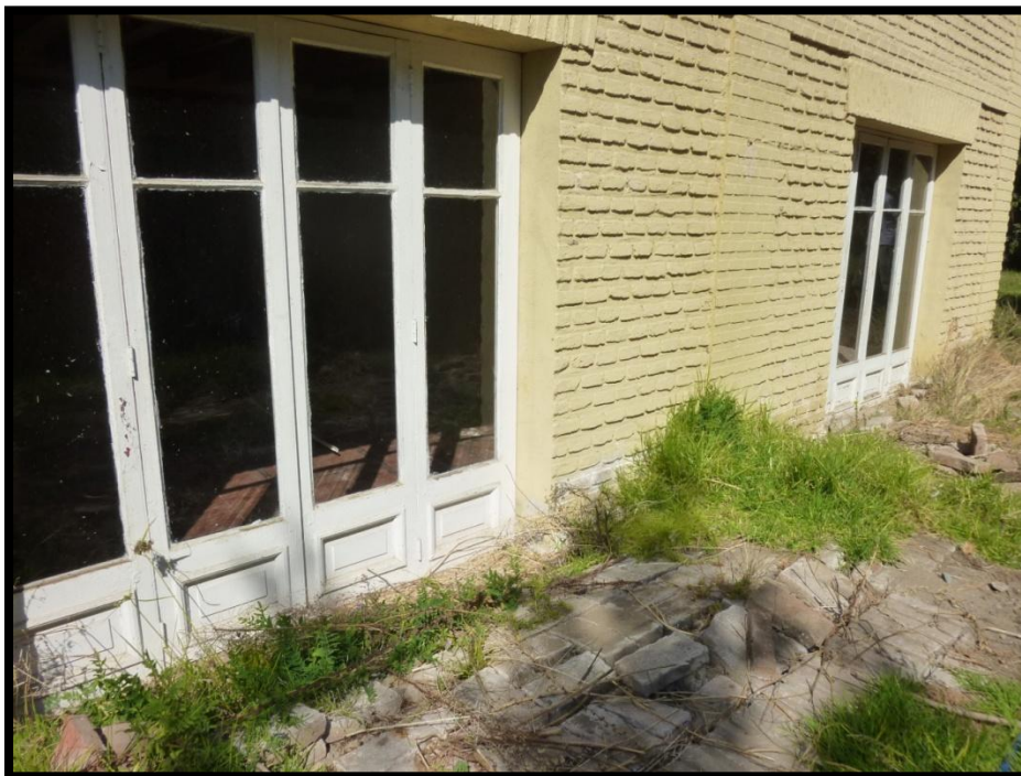
Fotografía 24. Asentamiento en una casa cercana la capilla de Abrantes, producto del terremoto del 2010. (Fotografía: Javiera González).
