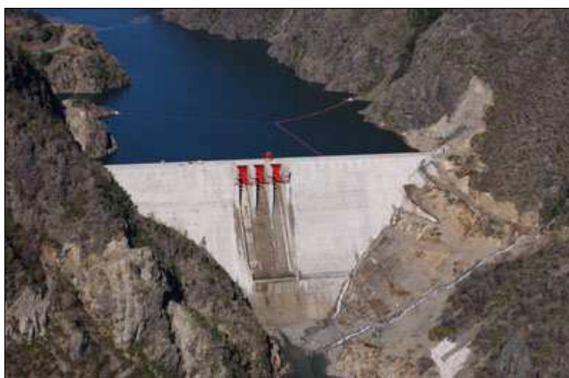
Figura 2: Embalse de central hidroeléctrica
