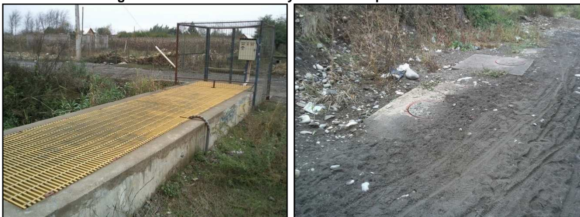
Imagen 12 Planta elevadora 1 y cámaras de planta elevadora 2
