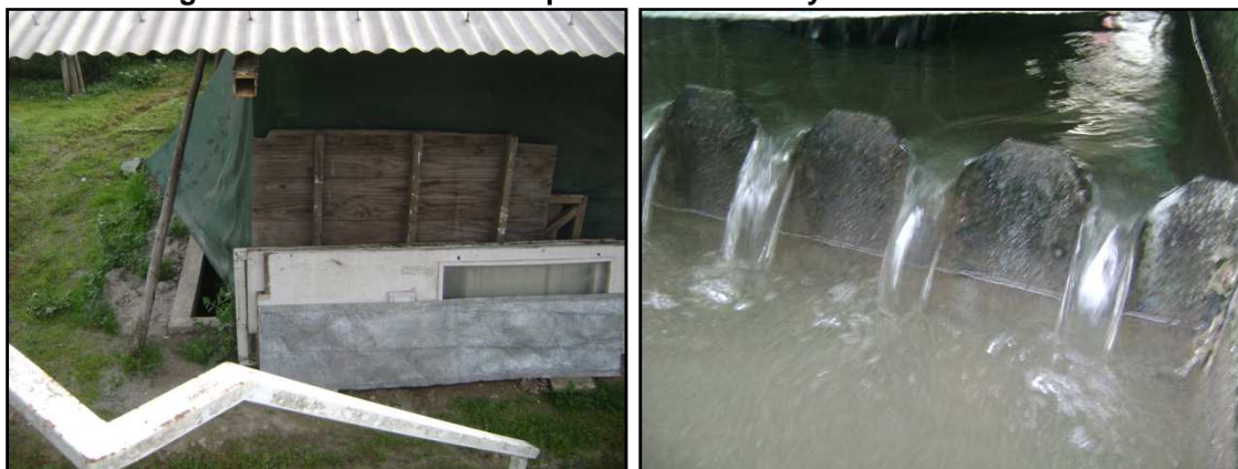
Imagen 86 Biodisco cubierto por malla Raschel y efluente del Biodisco
