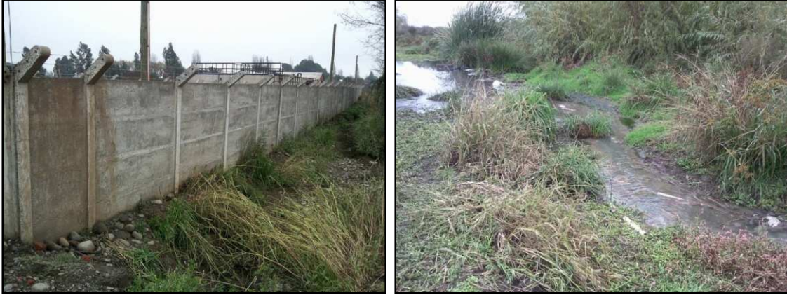
Imagen 18 Canal Santa Cristina y actual disposición de Aguas Servidas a Ribera de Río Lontué
