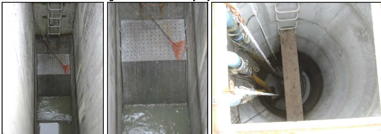
Imagen 81 Cámara de rejas y Planta de elevación
