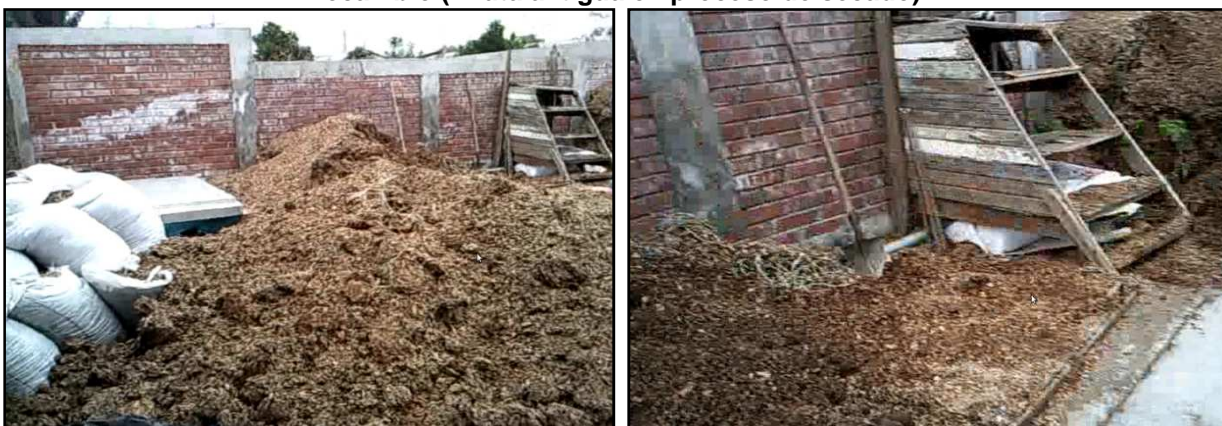
Imagen 64 Vista en elevación del Lombrifiltro, escalera de acceso y punto de acopio de viruta de recambio (viruta antigua en proceso de secado)
