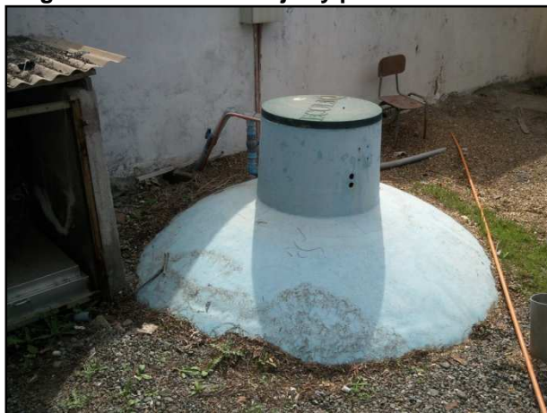
Imagen 94 Cámara de rejas y planta de elevación
