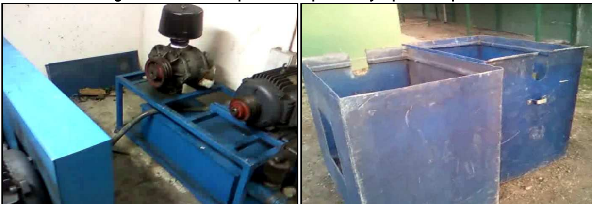
Imagen 119 Vista de soplador en reparación y tapas de sopladores
