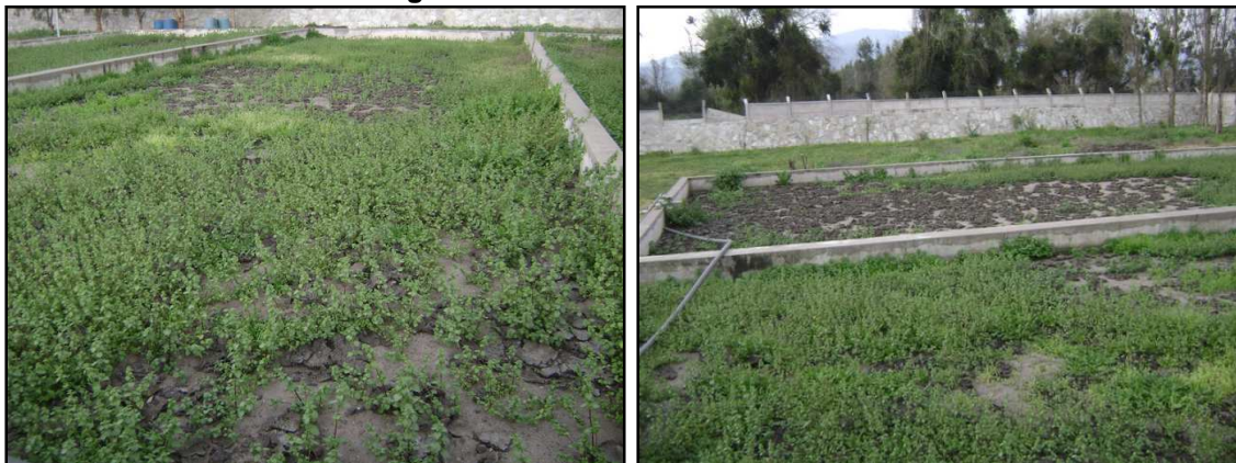
Imagen 92 Cancha de secado de lodos
