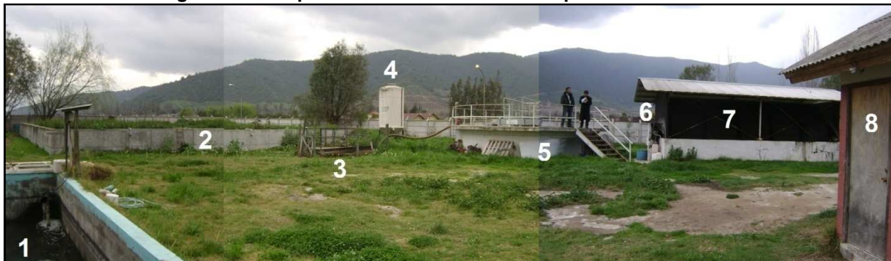
Imagen 70 Vista panorámica de unidades componentes de la PTAS
