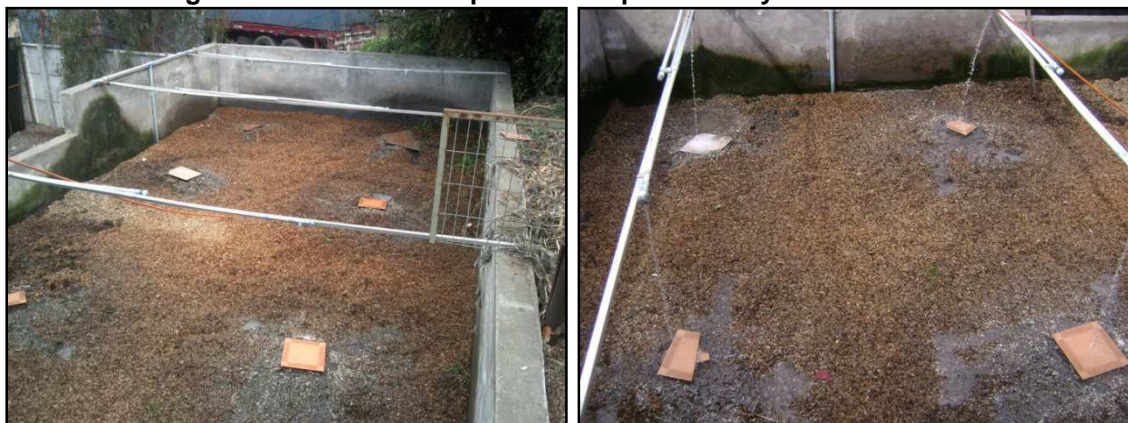
Imagen 96 Vista de los aspersores superficiales y lecho del Biofiltro
