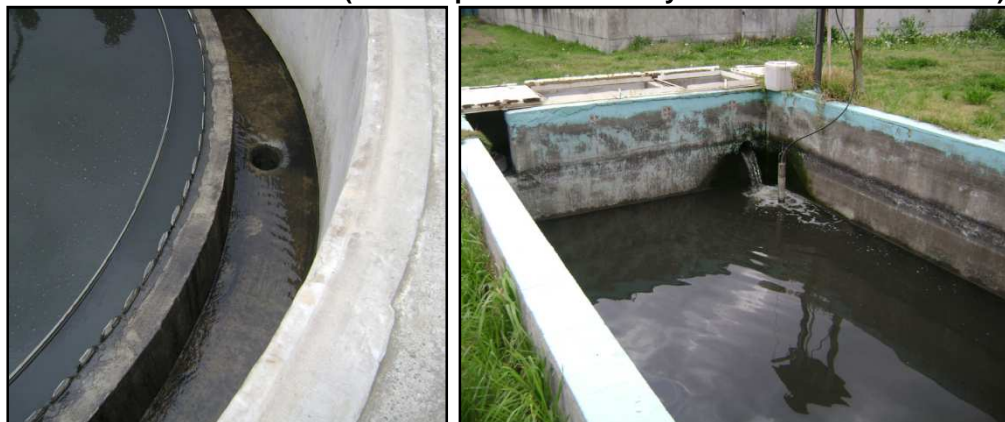
Imagen 76 Vista del vertedero de salida del sedimentador y entrada a la cámara de contacto de desinfección (sin tabiques deflectores y sin realizar desinfección)
