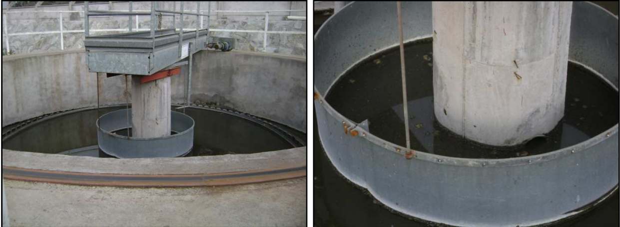
Imagen 87 Sedimentador secundario
