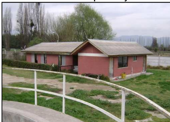
Imagen 69 Vista vivienda del Operador y cuarto de bodega
