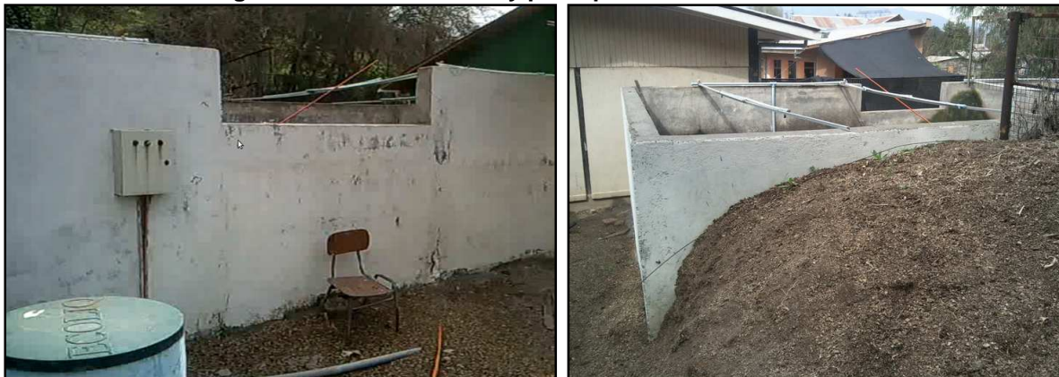
Imagen 95 Vista del frontis y parte posterior del Lombrifiltro
