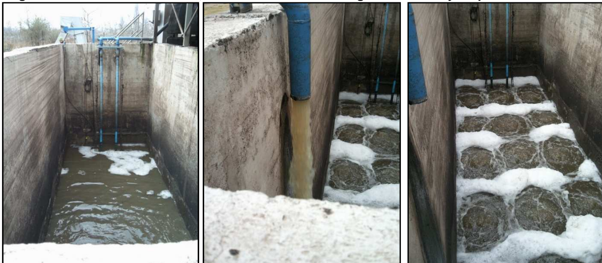
Imagen 52 Ecuador detenido, recibiendo afluente de aguas servidas y en proceso de aireación
