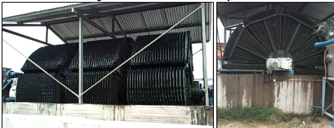
Imagen 53 Vista lateral de Biodiscos y Rotor
