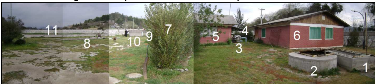
Imagen 80 Vista panorámica de unidades componentes de la PTAS
