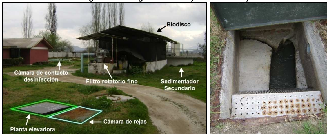
Imagen 71 Vista general PTAS y Cámara de rejas
