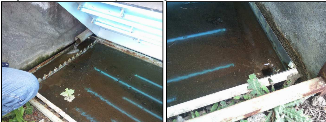
Imagen 99 Vista de la entrada y salida del agua clarificada en la cámara de desinfección
