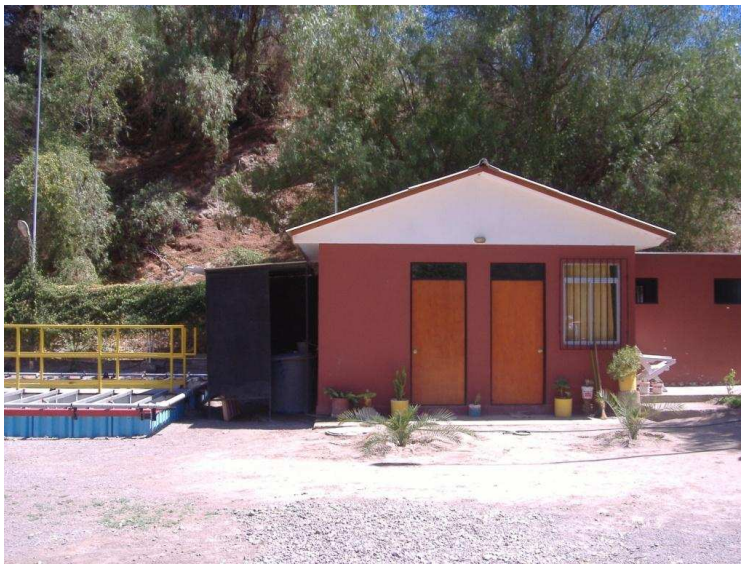
Sala de Control e instalaciones
