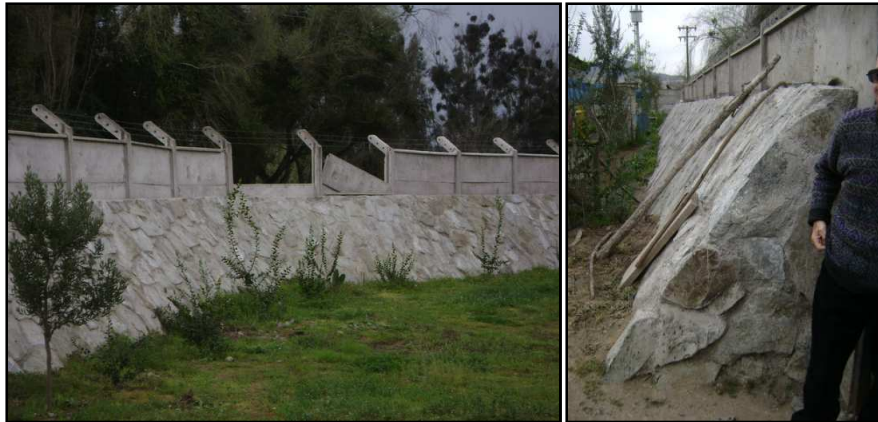
Imagen 90 Fortificación del cierre perimetral de la PTAS
