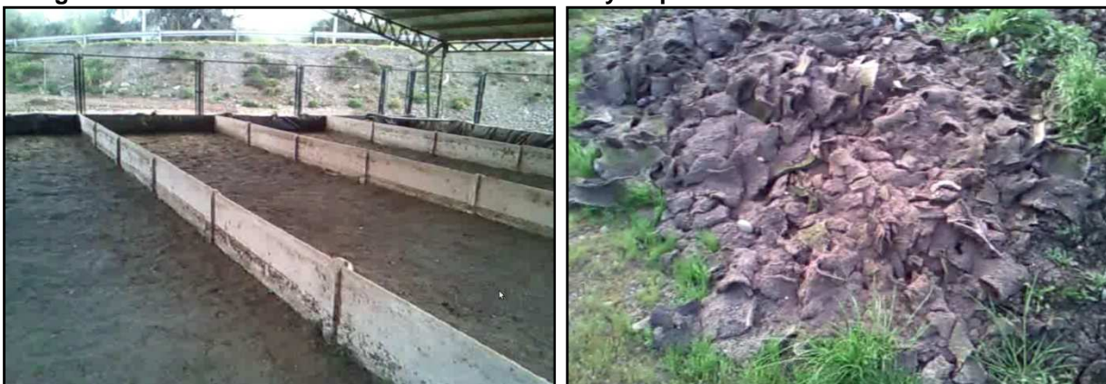
Imagen 122 Cancha de secado de lodos con techo y disposición final de lodos secos en el suelo
