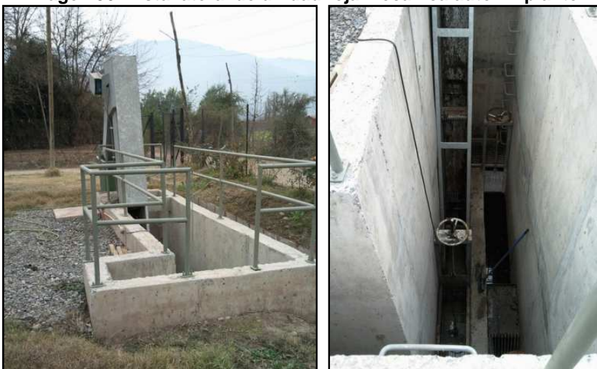
Imagen 50 Vista lateral de unidad reja mecánica auto limpiante
