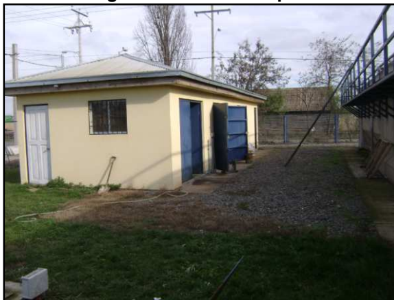
Imagen 24 Casa de Máquinas
