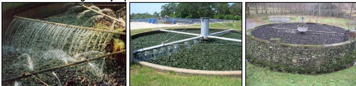
Imagen 4 Ejemplos de sistemas de tratamiento de Biofiltros
