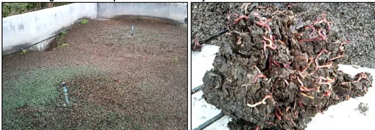
Imagen 65 Vista en planta del Lombrifiltro y muestreo de lombrices en la viruta
