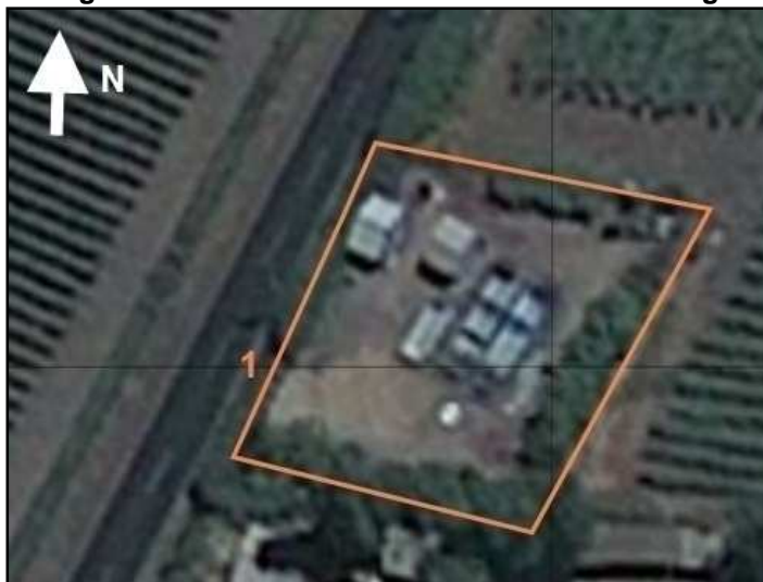
Figura 43 Imagen satelital de la Planta de Tratamiento de Aguas Servidas
