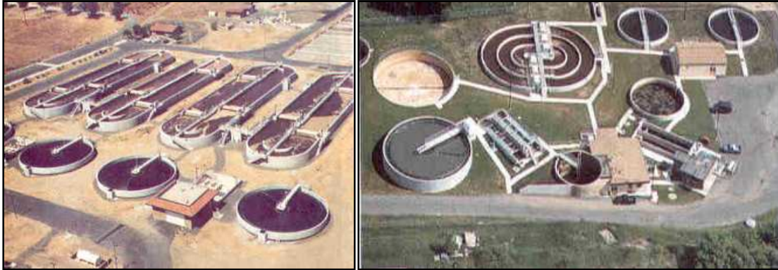
Imagen 8 Zanja de Oxidación sistema Carrusel, sistema Orbital
