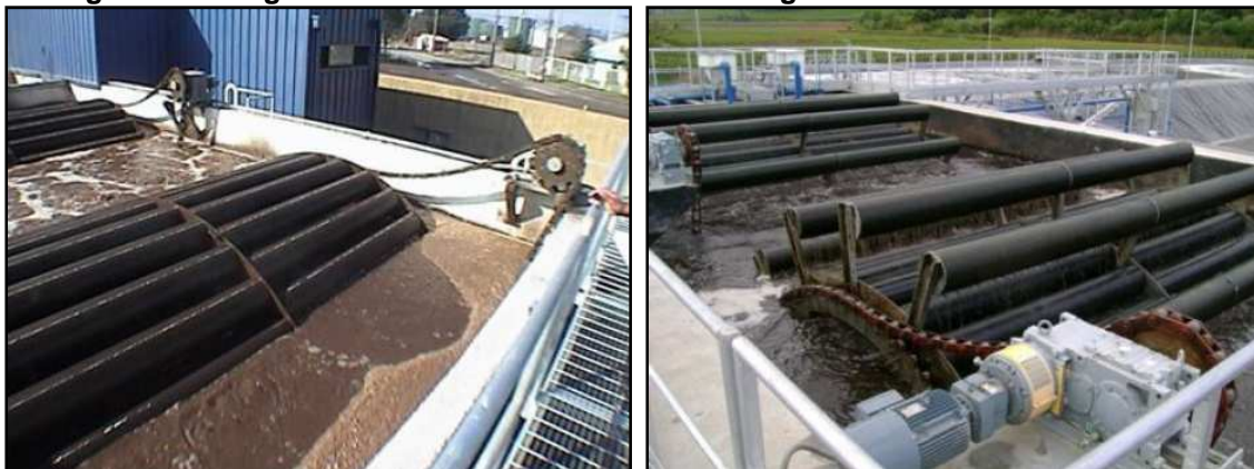
Imagen 111 Imágenes referenciales del reactor biológico de la PTAS en construcción
