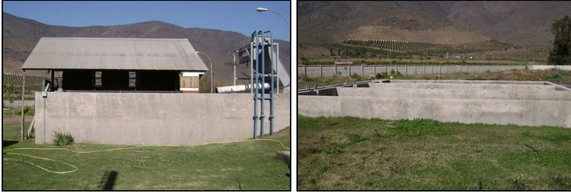
Imagen 29 Vista lateral de biodiscos, filtro estático fino y canchas de secado de lodos
