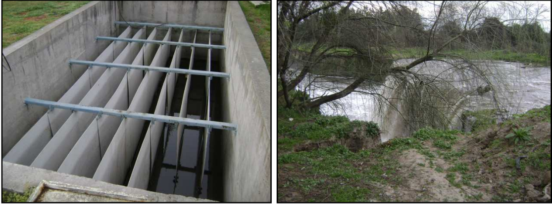
Imagen 89 Cámara de contacto desinfección y lugar de disposición del efluente de la PTAS
