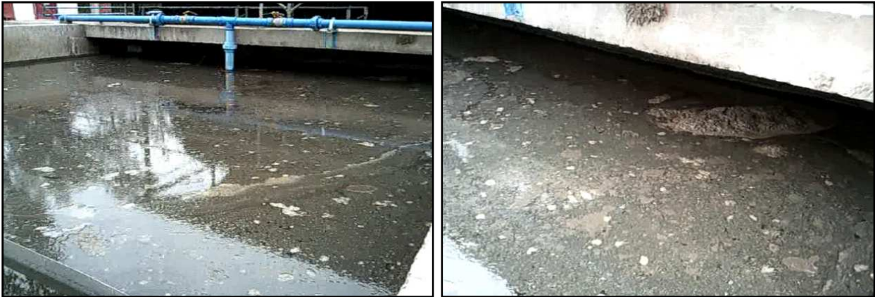
Imagen 54 Vista lateral del sedimentador secundario y lodos aglomerados en resuspensión
