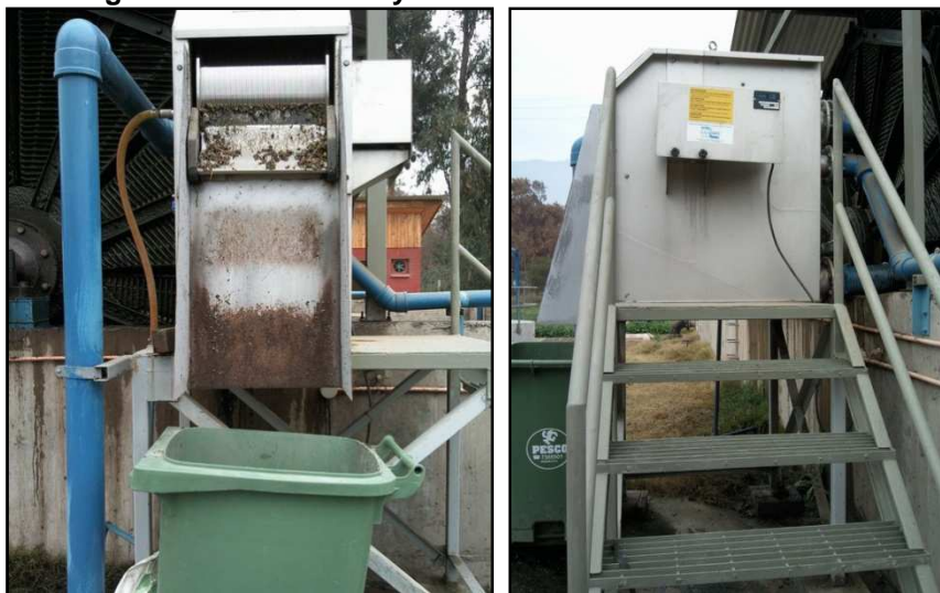
Imagen 51 Vista frontal y lateral de filtro de tambor rotatorio
