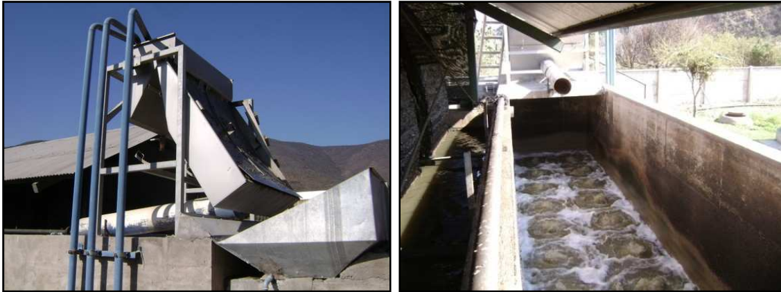
Imagen 30 Filtro estático fino con bandeja de estruje y estanque equalizador
