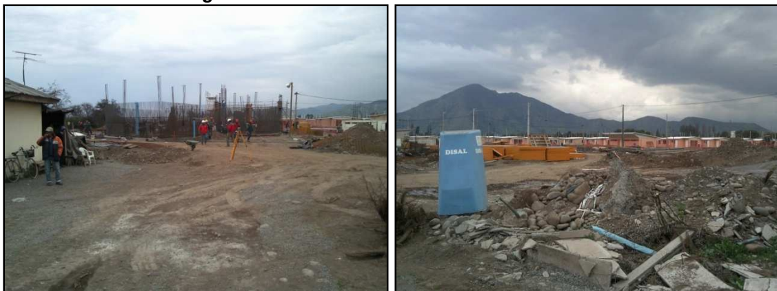
Imagen 110 Planta de Tratamiento en construcción
