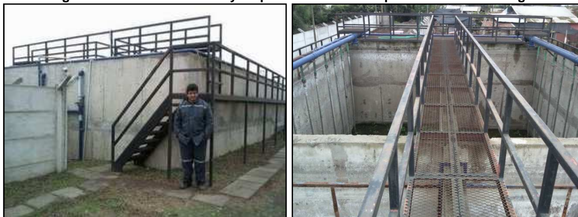
Imagen 13 Vista en elevación y en planta de los estanques del reactor biológico
