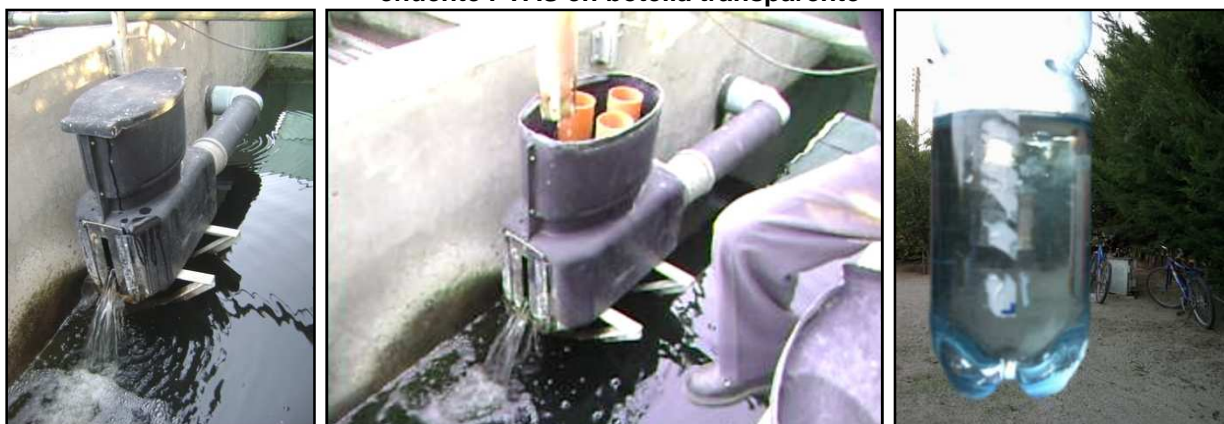
Imagen 48 Dispositivo de desinfección con tubos para el depósito de pastillas y muestra de efluente PTAS en botella transparente
