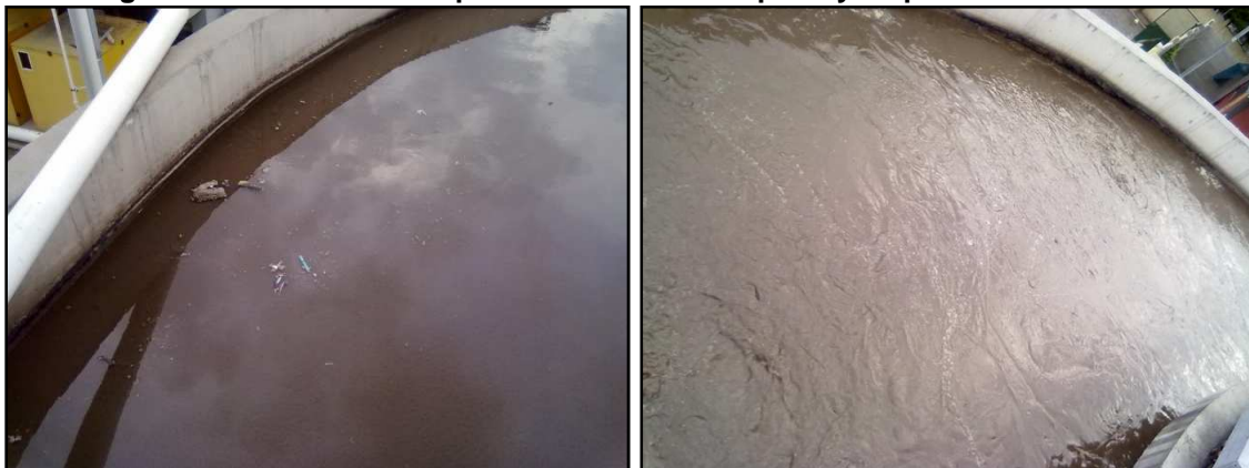
Imagen 102 Vista de estanque de aireación en reposo y en proceso de aireación
