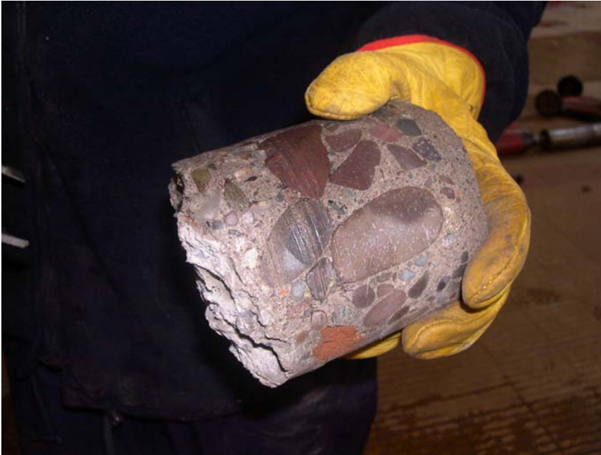
Foto N°45 : Proceso de extracción de testigos
