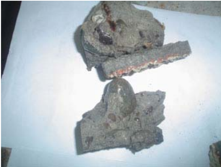
Foto N°55 : Determinación de la profundidad de carbonatación
