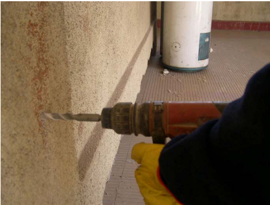
Foto N°54 : Proceso de extracción de testigos
