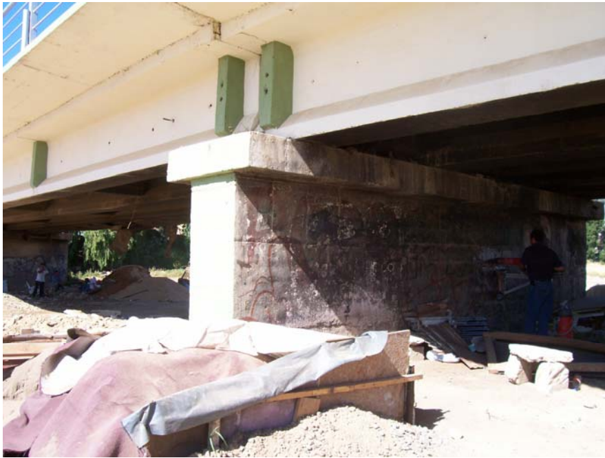
Foto N°13 : Vista cepa Puente Mercado
