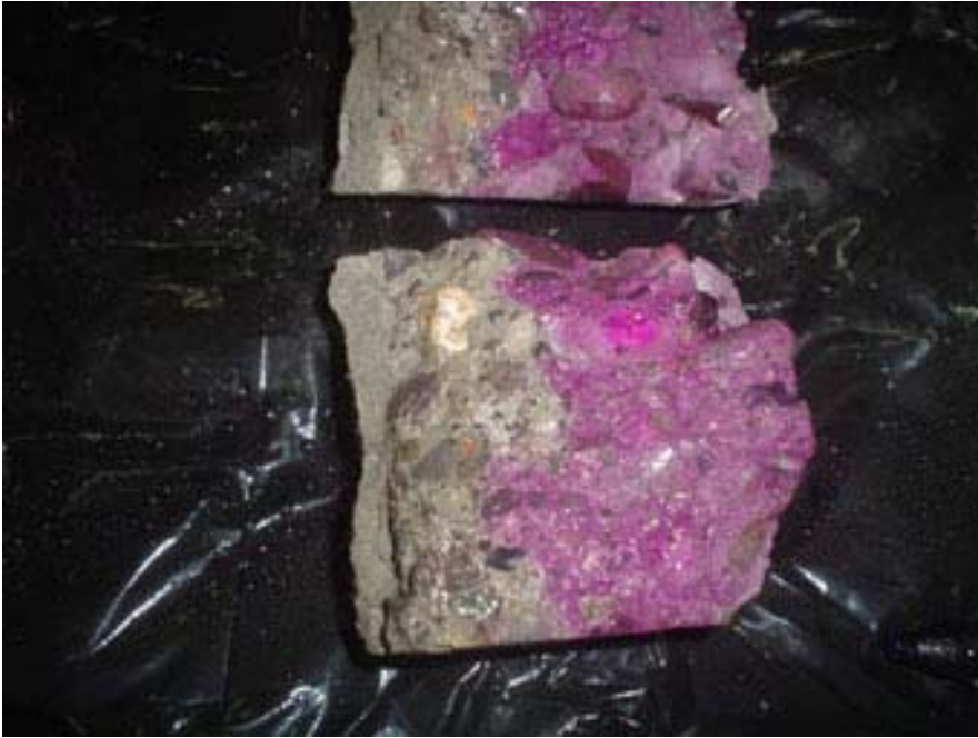
Foto N°57 : Determinación de la profundidad de carbonatación
