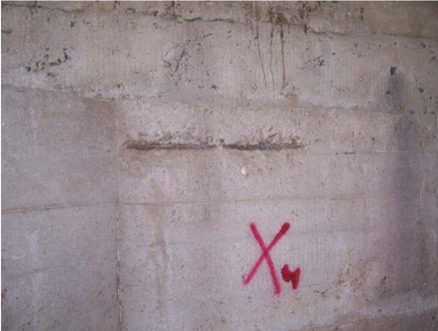
Foto N° 29: Marcación de los puntos para la extracción de testigos
