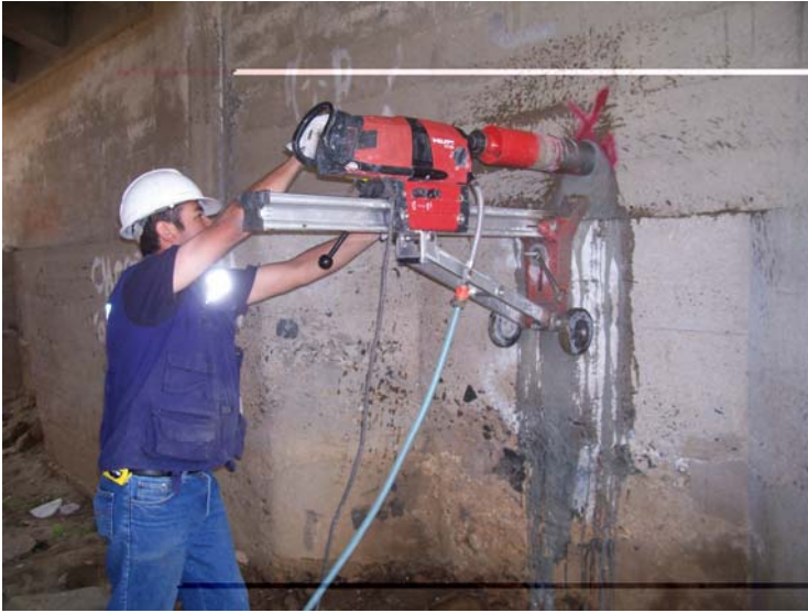
Foto N°4: Ejemplo uso testiguera Puente Quillota
