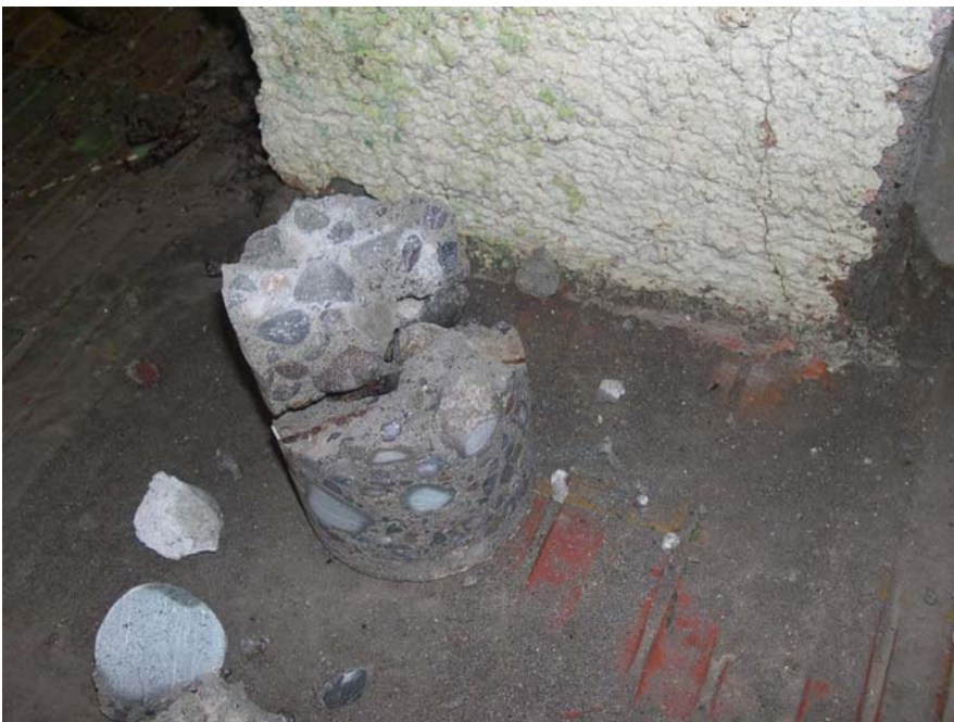
Foto N°46 : Proceso de extracción de testigos
