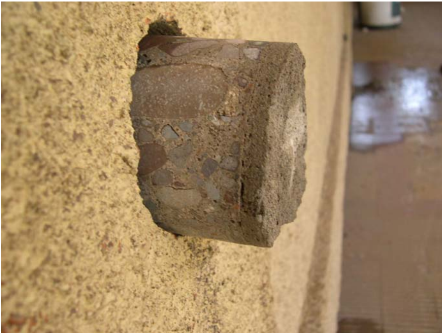
Foto N° 44: Proceso de extracción de testigos
