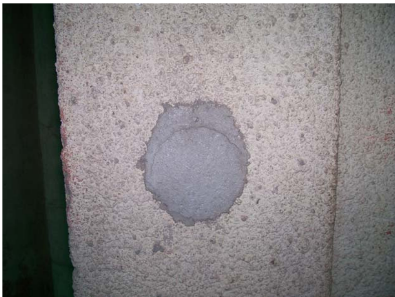
Foto N° 3: Ejemplo de reparación Internado Nacional Barros Arana
