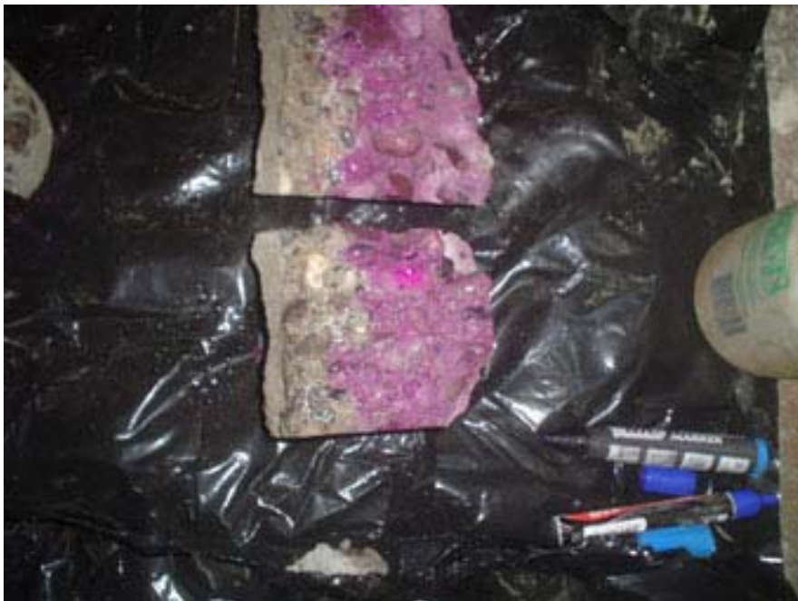
Foto N°56 : Determinación de la profundidad de carbonatación
