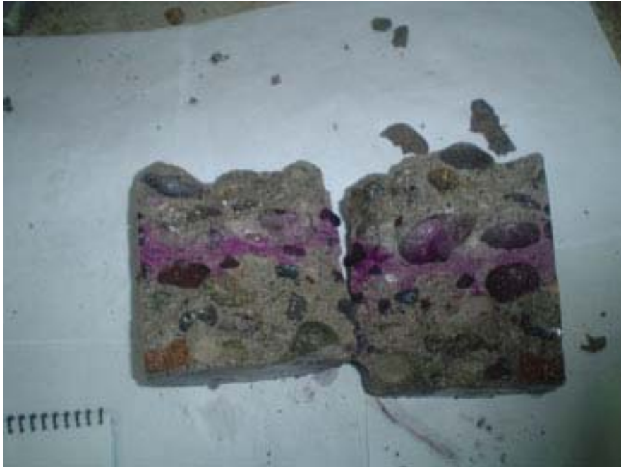
Foto N°63 : Determinación de la profundidad de carbonatación. No existe carbonatación en el centro del testigo
