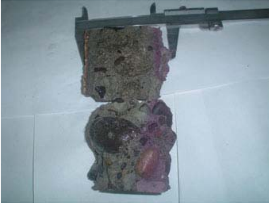
Foto N° 61: Determinación de la profundidad de carbonatación
