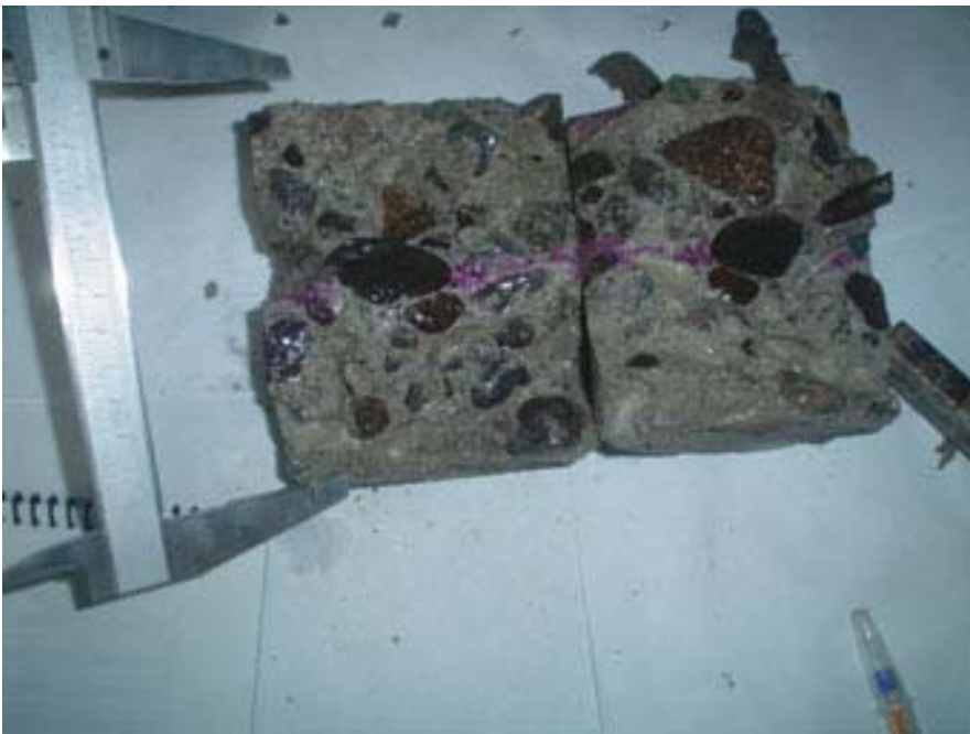
Foto N°68 : Determinación de la profundidad de carbonatación
