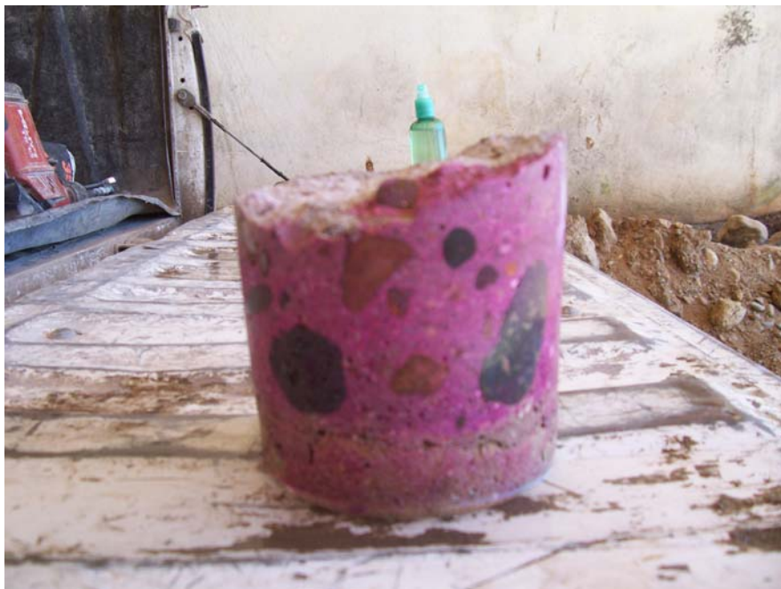
Foto N°80 : Medición profundidad de carbonatación
