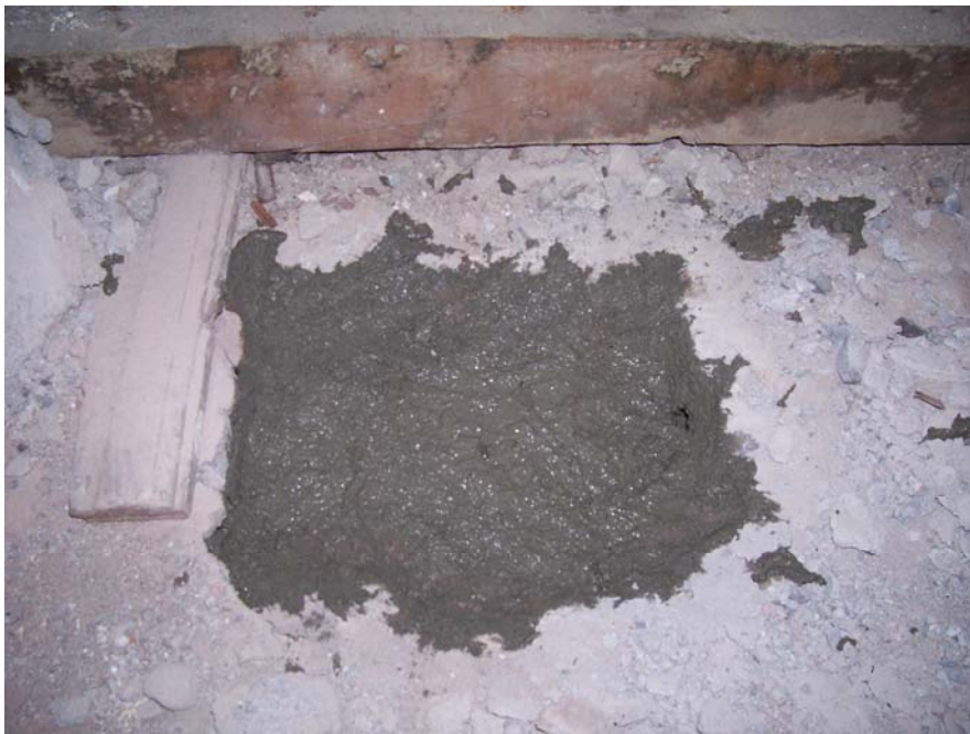
Foto N°76: Reparación daños losa sala de Títulos y Grados
