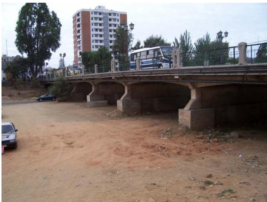
Foto N° 11: Vista general Puente Quillota
