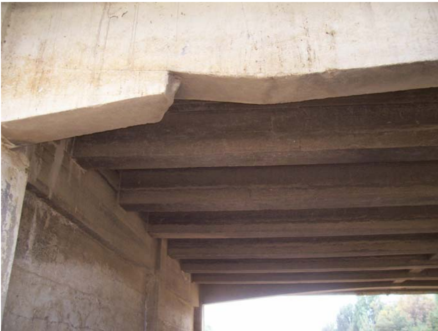
Foto N°30 : Vista vigas y cepa
