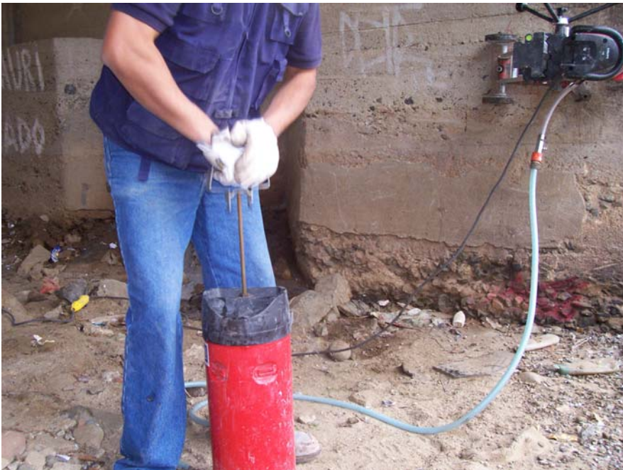
Foto N°22 : Proceso de extracción de testigo
