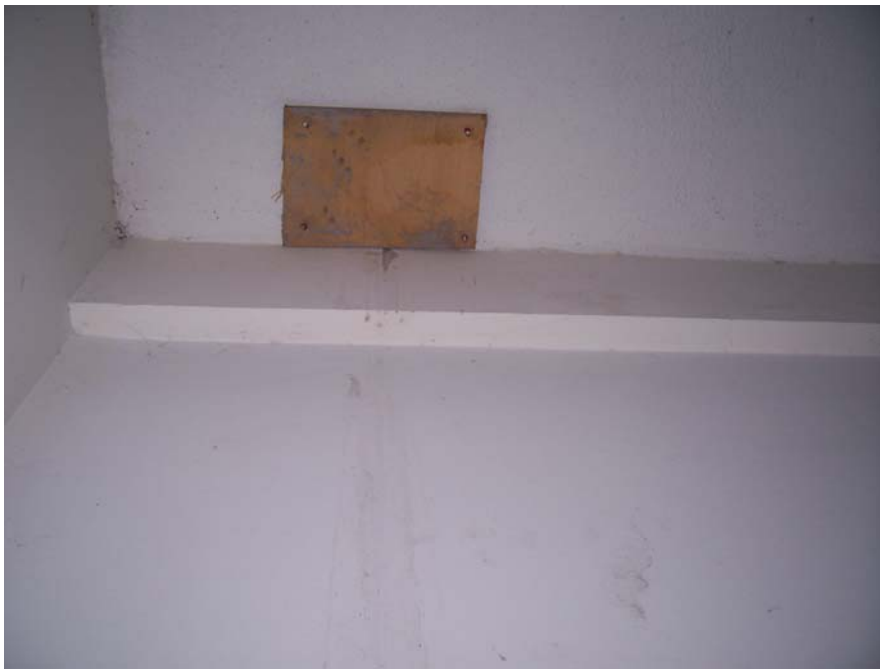
Foto N°73 : Reparación daños losa sala 18-sur
