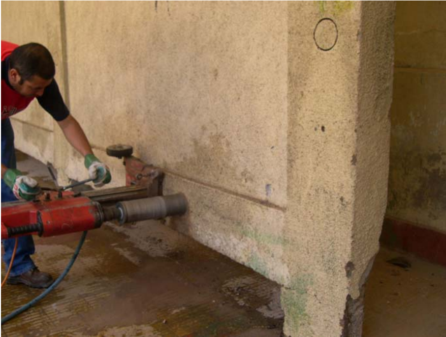
Foto N°51 : Proceso de extracción de testigos
