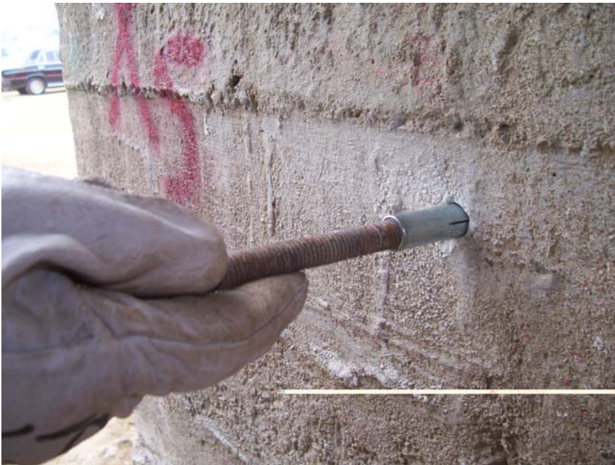
Foto N°26 : Montaje del equipo para la extracción de testigos
