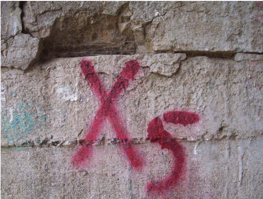
Foto N°28 : Marcación de los puntos para la extracción de testigos
