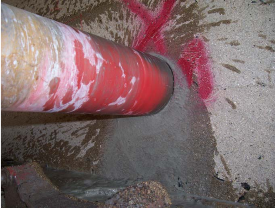
Foto N° 23: Proceso de extracción de testigo
