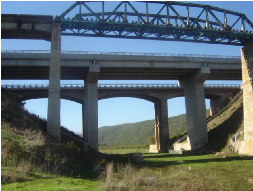
Foto N° 14: Vista general Puente Huaquén
