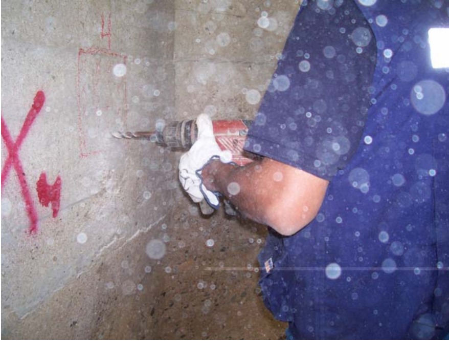
Foto N° 27: Montaje del equipo para la extracción de testigos
