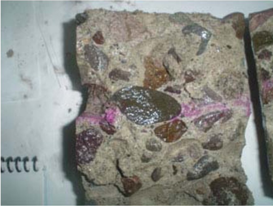
Foto N°67 : Determinación de la profundidad de carbonatación
