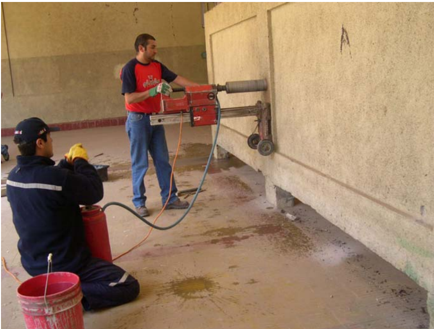
Foto N°52 : Proceso de extracción de testigos
