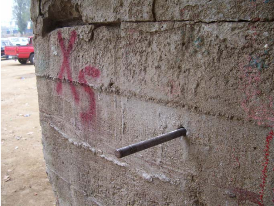
Foto N° 25: Montaje del equipo para la extracción de testigos
