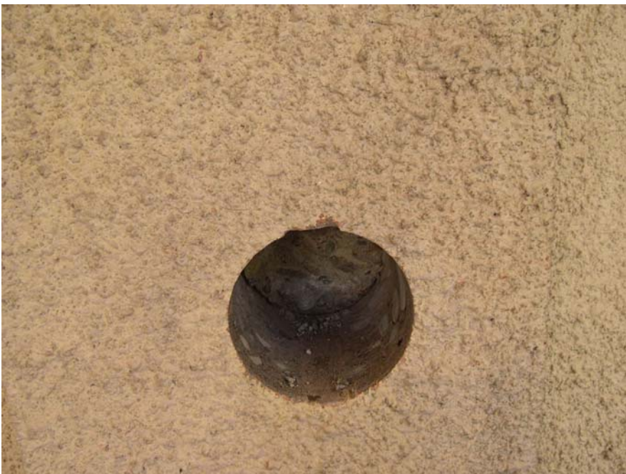
Foto N° 42: Proceso de extracción de testigos
