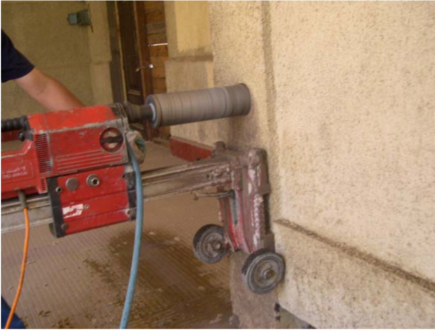
Foto N° 53: Proceso de extracción de testigos
