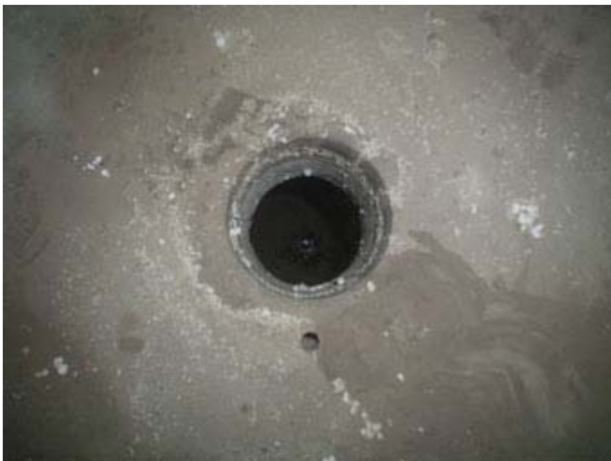
Foto N°69 : Determinación de la profundidad de carbonatación
