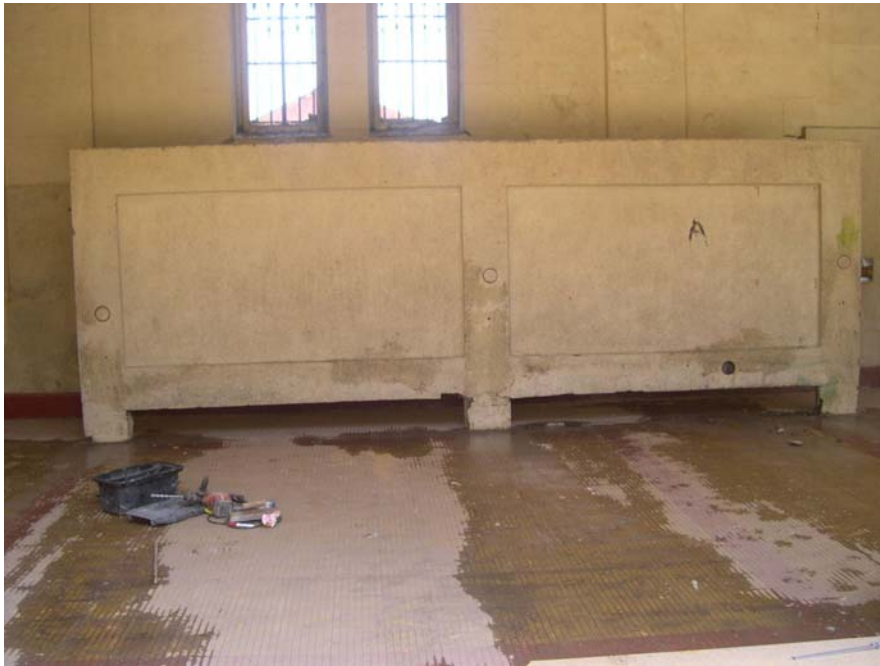
Foto N°49 : Vista general muro
