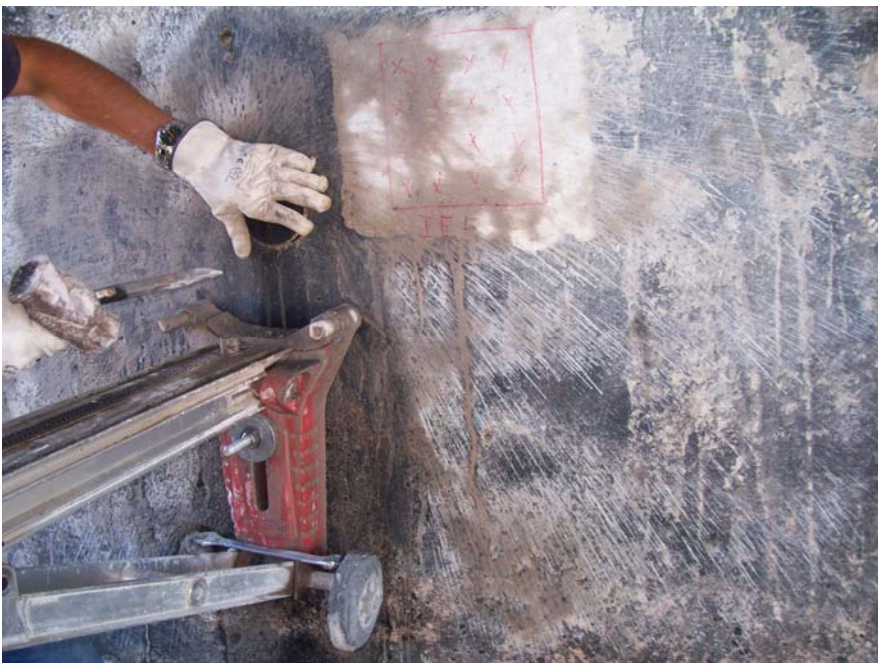
Foto N°84 : Extracción de testigos
