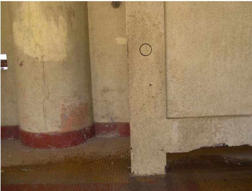
Foto N°48 : Marcación de los puntos para la extracción de testigos
