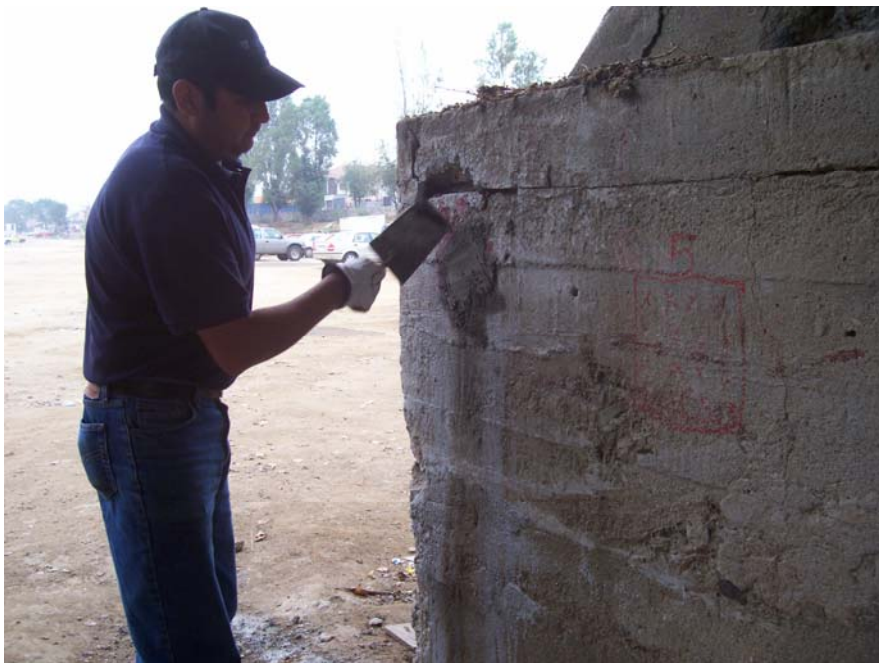
Foto N° 20: Reparación del daño producido a la cepa, con mortero de buena calidad
