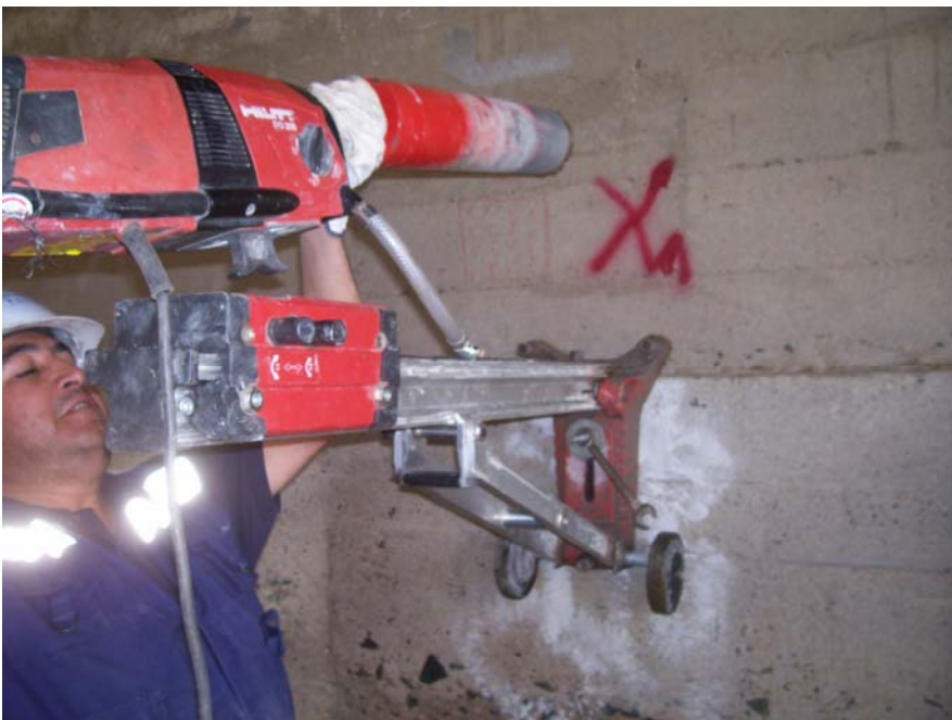
Foto N° 24: Montaje del equipo para la extracción de testigos
