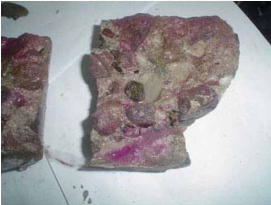
Foto N° 65: Determinación de la profundidad de carbonatación
