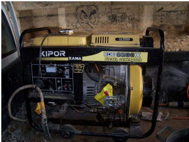
Foto N° 6: Generador eléctrico usado en Puente Quillota
