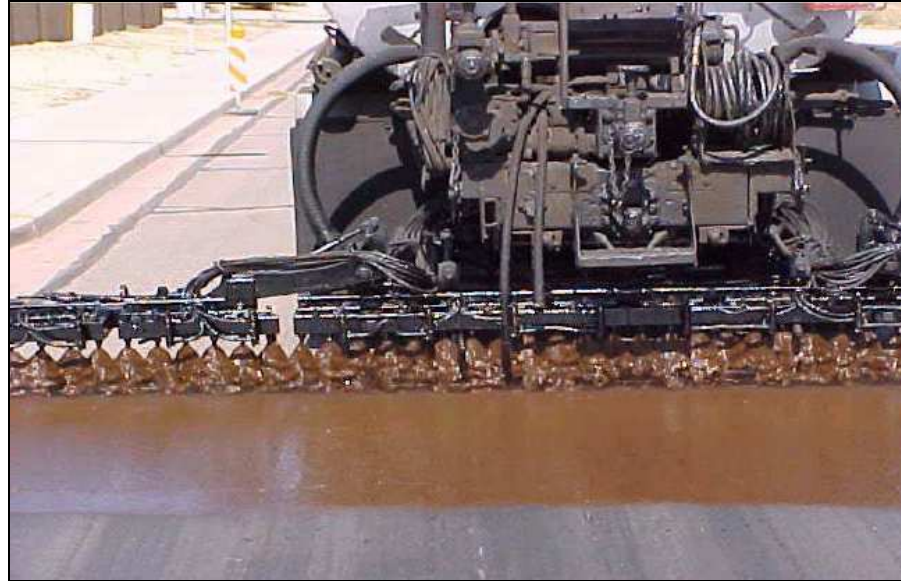
Figura N° 2.2: Aplicación de Riego de Liga. Camión bomba con barra esprayadora [5].
