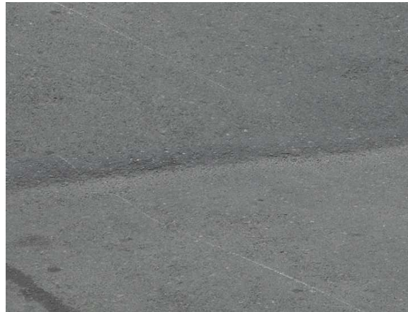
Figura N° 1.4: Arrollamiento Transversal
