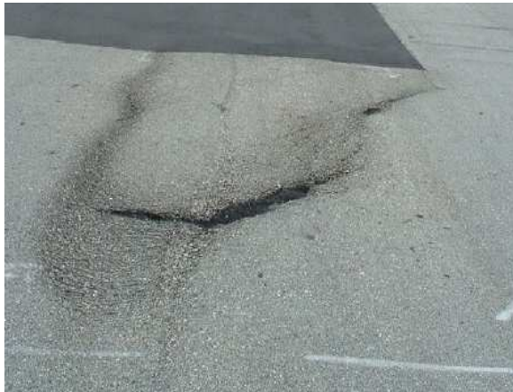
Figura N° 1.3: Fisura o grieta parabólica
