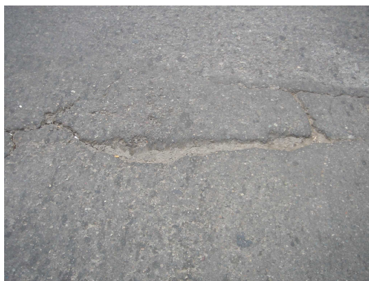
Figura N° 1.2: Falla de deslizamiento de carpeta superior
