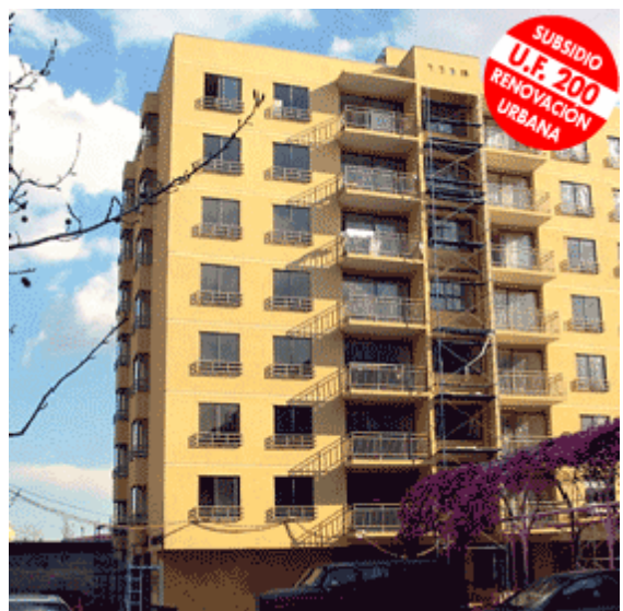
Imagen N° 3: Edificio Los Maitenes II.
