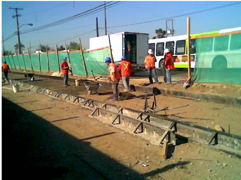
Fotografía 2 : Moldes Alineados y Nivelados
