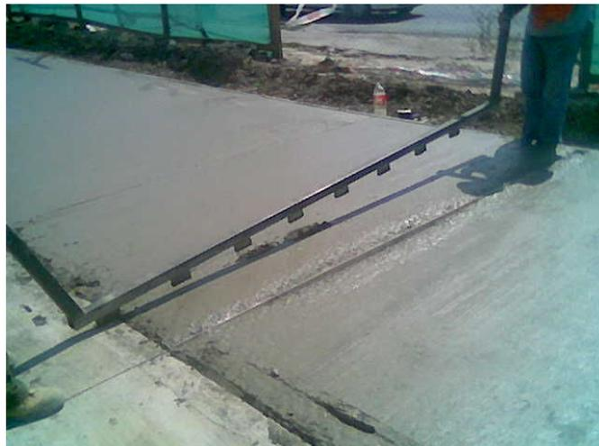
Fotografía 2: Construcción Junta Transversal de Contracción
