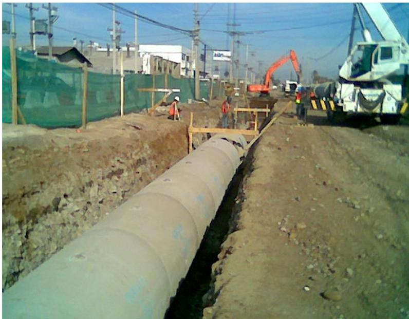
**Tubería de Cemento Comprimido**
