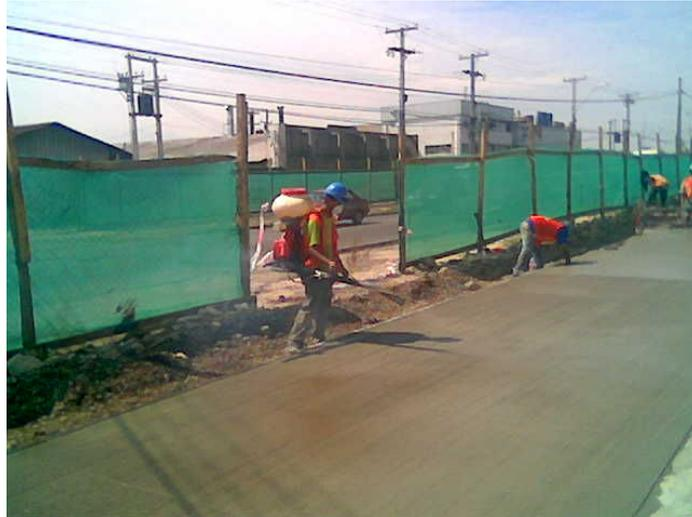
Fotografía 3: Curado del Hormigón
