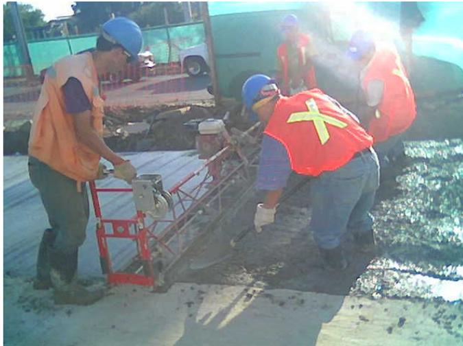
Fotografía 1: Compactación con Cercha Vibradora
