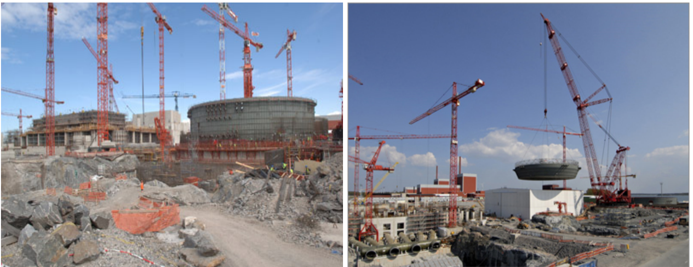
Figura 2.16: Avance de las estructuras internas y de los edificios de contención
