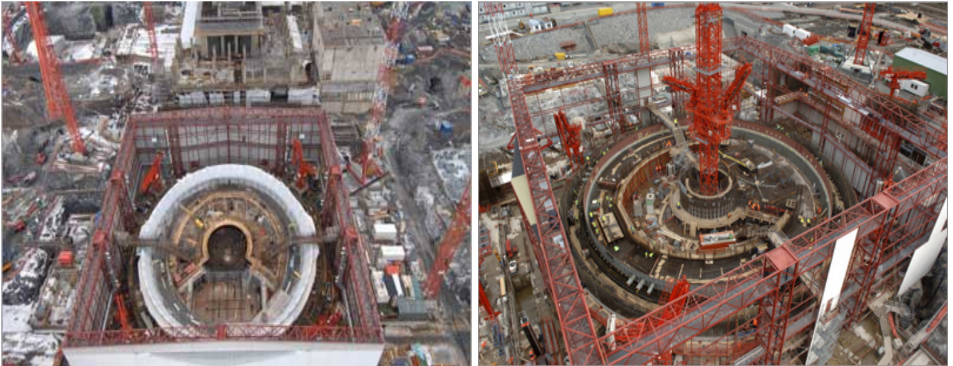
Figura 2.14: Enfierradura y moldajes de muros diagonales para zona de la vasija del reactor. Enfierradura de Losas
