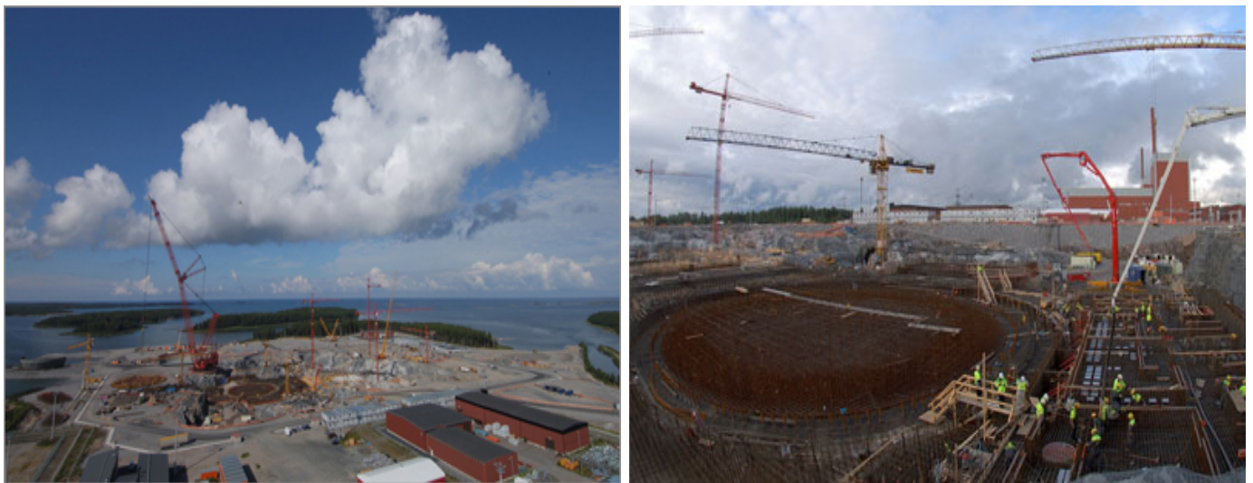
Figura 2.8: Colocación de armaduras en la losa de fundación
