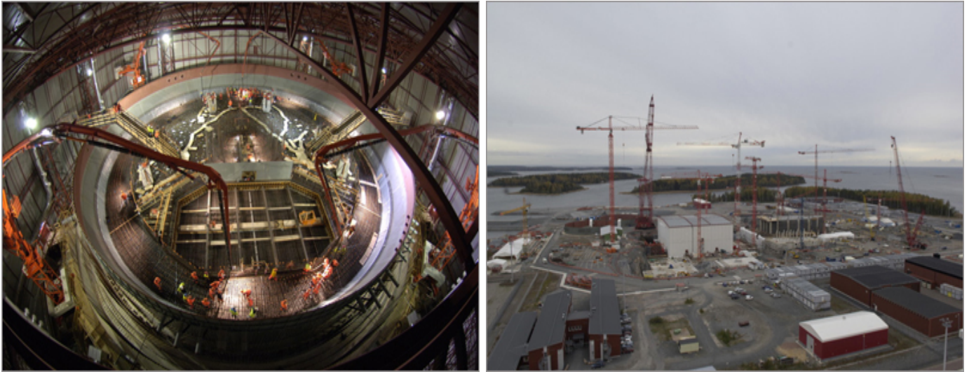
Figura 2.11: Colocación de moldajes para los muros internos del reactor, zona de la vasija y zona de almacenamiento en caso de derretimiento del núcleo
