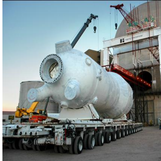
Figura 2.5: Modelo de la vasija del reactor en la que se aprecia su sistema de tuberías y de apoyo. Transporte de la vasija del reactor
