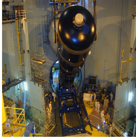
Figura 2.6: Modelo del generador de vapor en la que se aprecia su sistema de apoyo. Instalación de un generador de vapor en la planta nuclear
