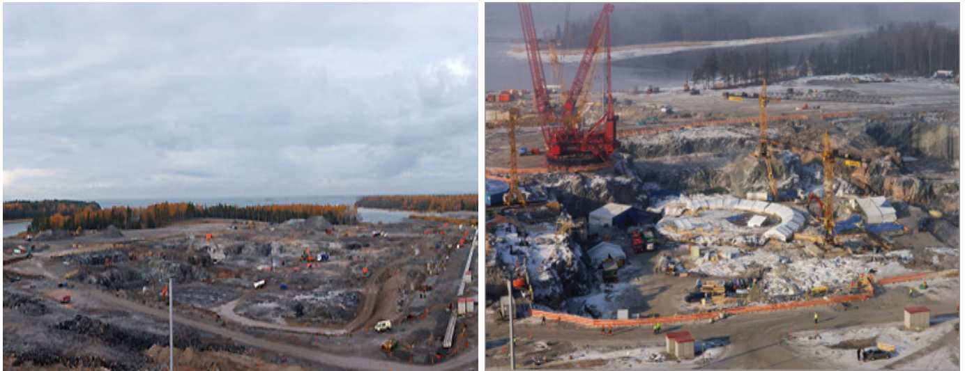
Figura 2.7: Excavación en el sitio seleccionado. Colocación de grúas e instalaciones de faena
