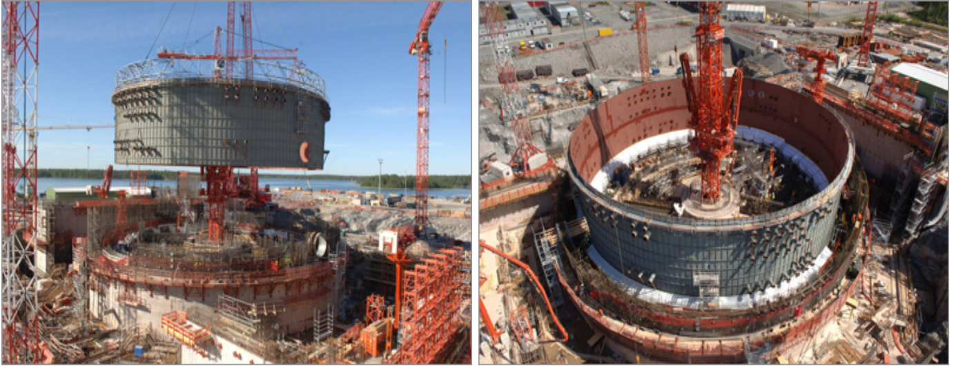
Figura 2.15: Colocación de módulos de acero para el edificio de contención. Instalación de grúas para la construcción de la zona de la vasija del reactor
