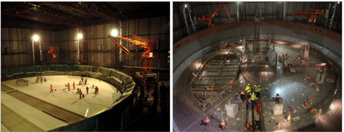
Figura 2.10: Losa de fundación del Edificio de Contención. Colocación de moldajes para los muros internos del reactor y zona de la vasija de reacción
