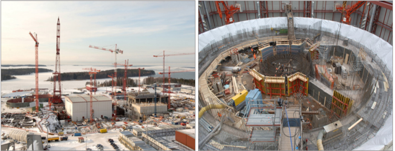
Figura 2.13: Vista general de las faenas. Enfierradura de muros diagonales para zona de la vasija del reactor y como apoyo de las losas
