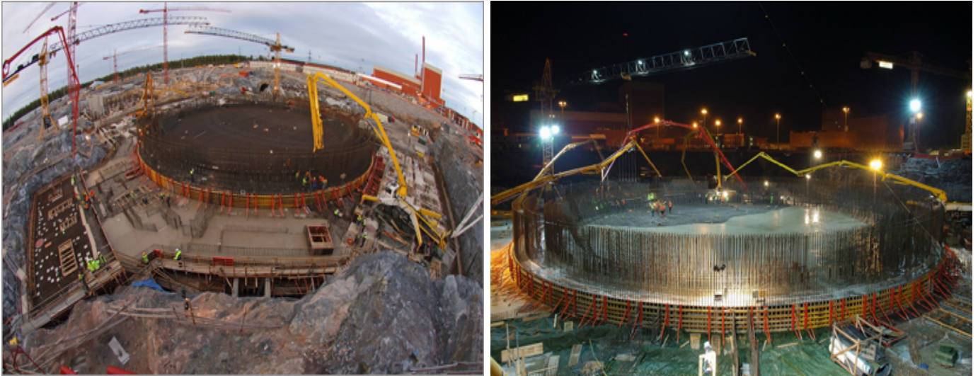
Figura 2.9: Colocación de moldajes para hormigonado de las estructuras. Vista de los trabajos nocturnos
