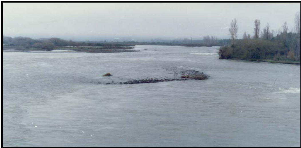
Ilustración 5.1: Avance de un banco de sedimentos en la poza de la bocatoma Laja Sur.
