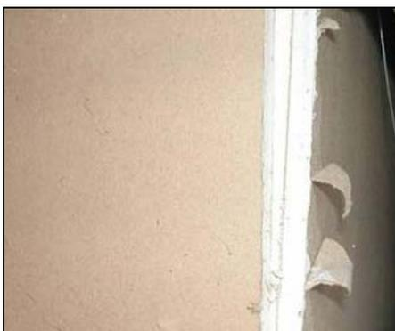
Figura 11. Daño a elemento de yeso cartón.
