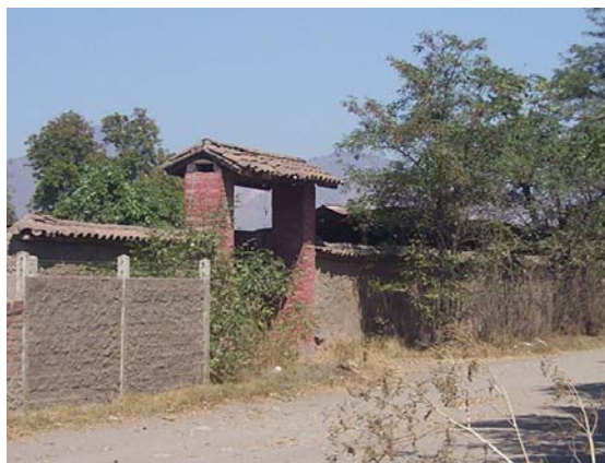
Construcciones del antiguo Fundo "Pérez Ossa"
