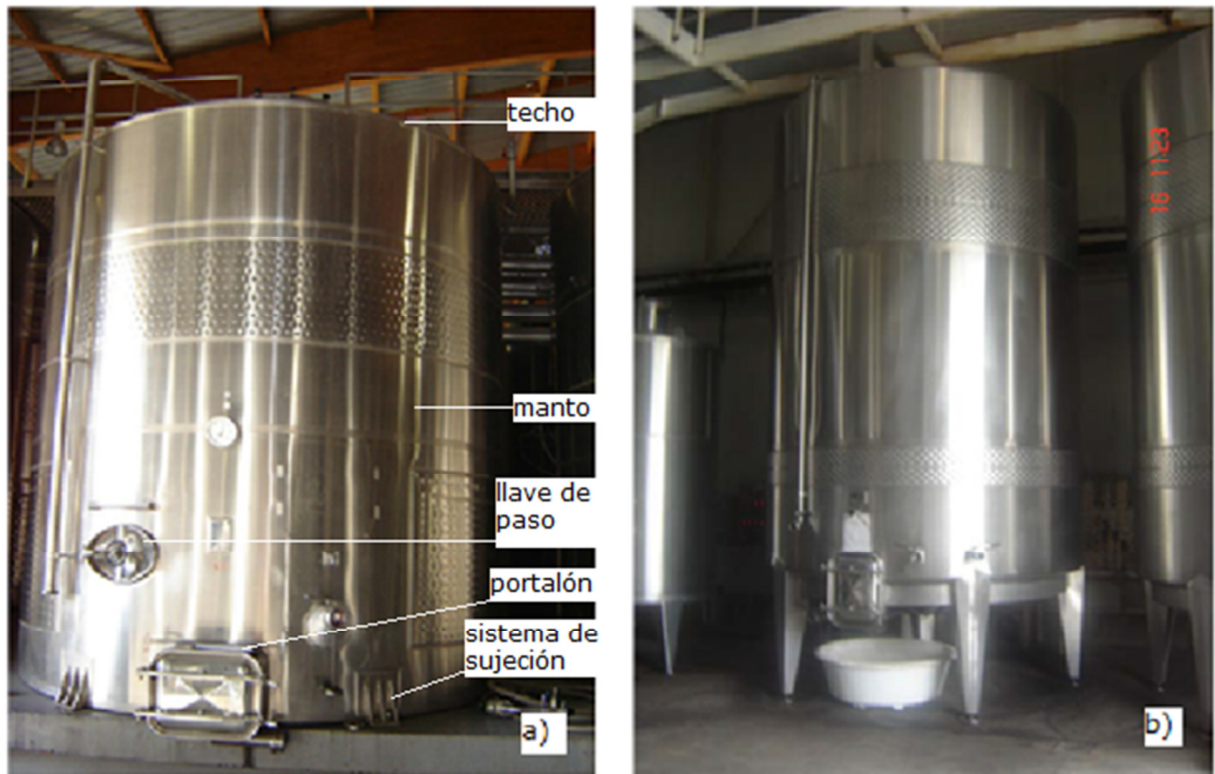
Figura 2-1: Tipos de estanque según apoyo. a) Estanque apoyado directamente sobre el suelo. b) Estanque con patas. [6]
