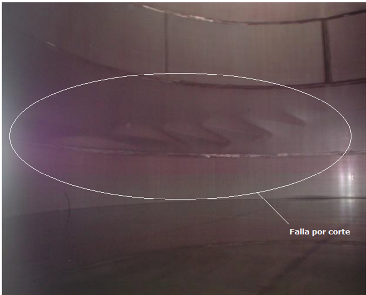
Figura 2-20: Falla por corte [2]
