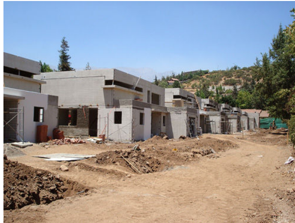
Figura 3.1 Vista general del proyecto.
