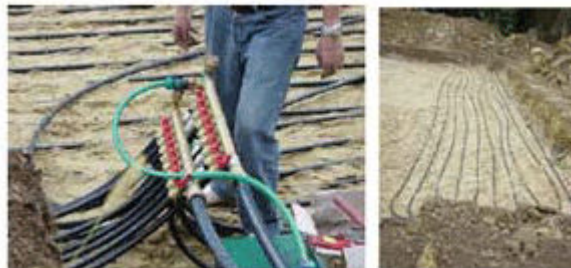
Figura 2.23 Captadores geotérmicos horizontales (29) .
