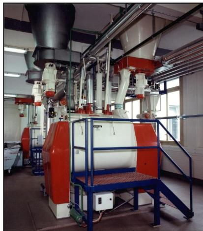
**Figura 2.2:** Mezclador materias primas. Marca Buhler. Fuente: Fábrica chocolates.
