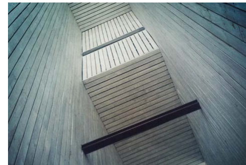
Imagen objetivo interiores.Revestimiento madera, Escuela de diseño P.U.C. (Campus Lo Contador), arquitecto: Sebastián Irarrázabal. Extraído en Junio de 2012 desde: http://www.flickr.com/photos/mdgarq/7367567300/
