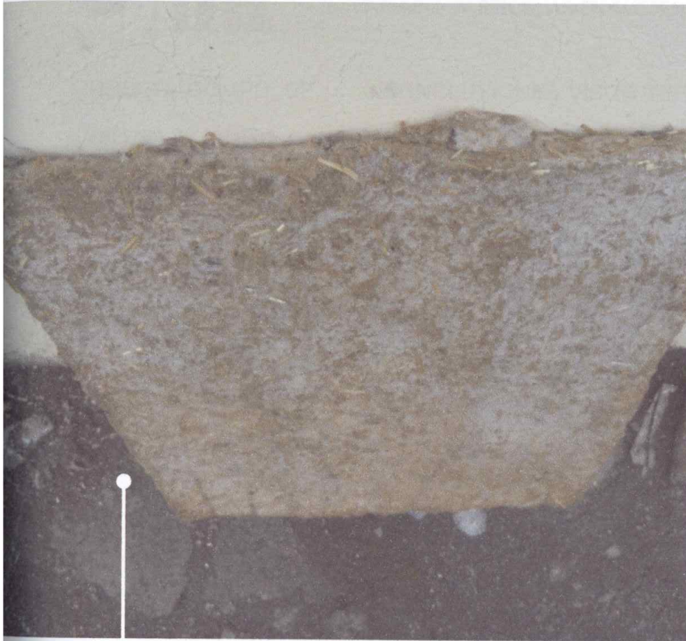
Material se ve desgastado en aristas y partes laterales expuestas
