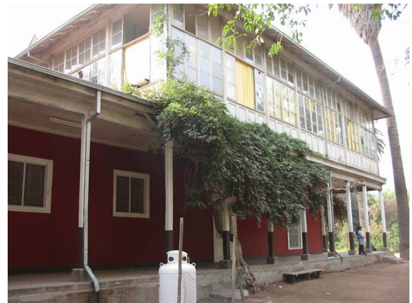
Volumen acristalado en segundo piso.
