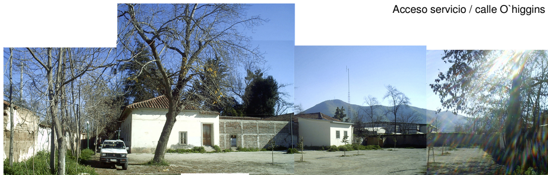
Casa patronal / muro anexo cierra el patio central / negación de relación casa - parque
