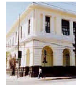
Edificio de correos Los Andes
