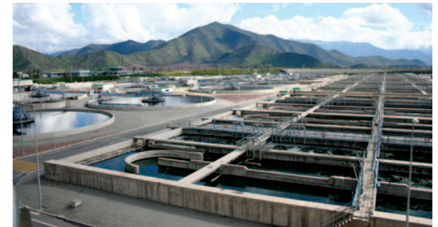
FOTO SATELITAL RUTAS SECTOR PLANTA DE TRATAMIENTO DE AGUAS LA FARFANA
