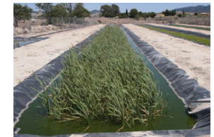
FILTRO DE DEPURACIÓN
