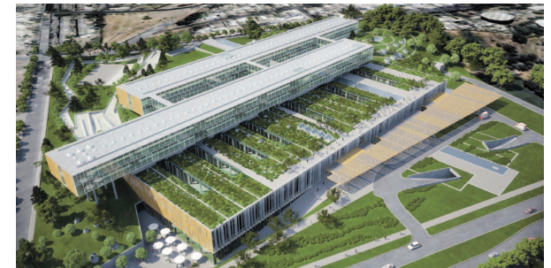
-HOSPITAL DR. LUIS VALENTÍN 2012 57% OBRA CONSTRUIDA
