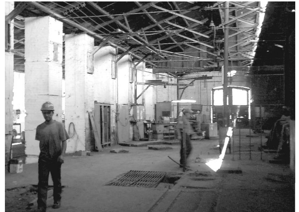
Vista del interior de las naves de albañilería
