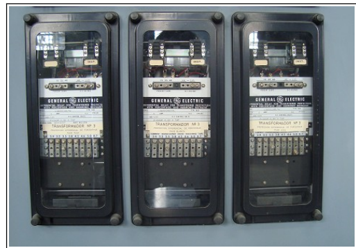
Figura 2.4 Relé electromecánico.
