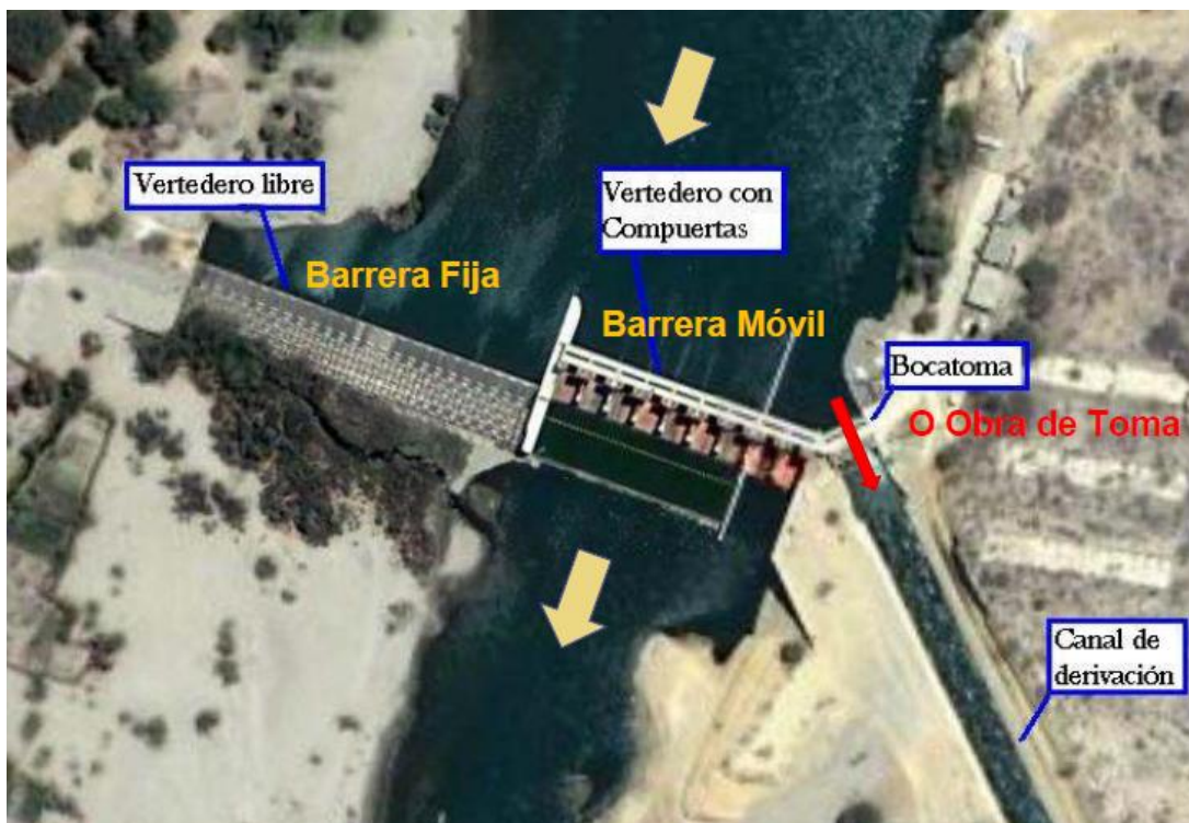
Figura 6-1: Obra de captación.
