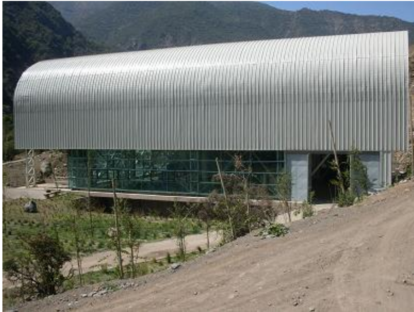
Figura 6-6: Casa de Máquinas, Central Guayacán.
