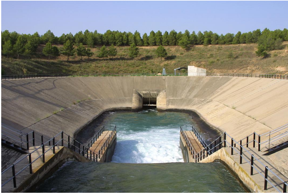
Figura 6-3: Cámara de carga.
