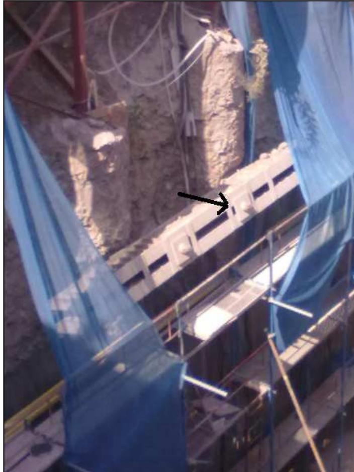
Figura 8. Tensores de acero de los Anclajes expuestos a condiciones de exposición ambiental.
