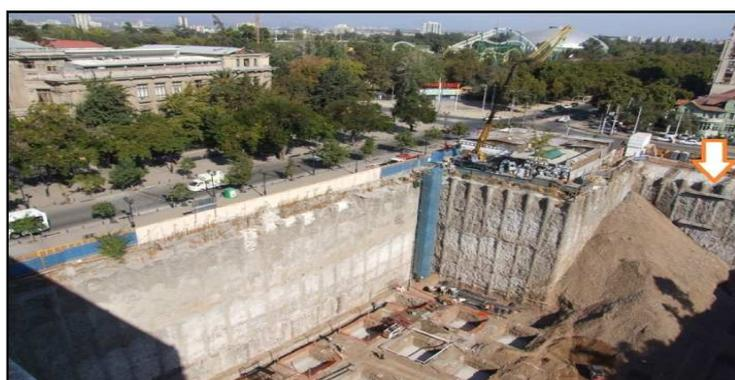
Figura 2. Ubicación de Pila de Entibación y sus Anclajes en Proyecto Beauchef 851.
