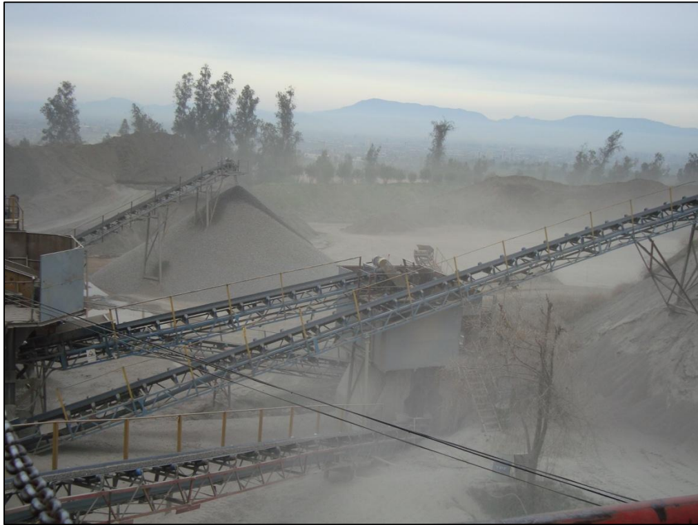
Figura 6. Vista de la planta de áridos.
