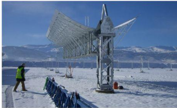
Figura 13: fotografía de Andasol 1 en construcción con nieve [23]
