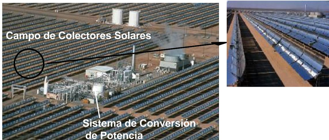
Figura 2.5: Vista general de una planta solar termoeléctrica con colectores cilindro-parabólicos
