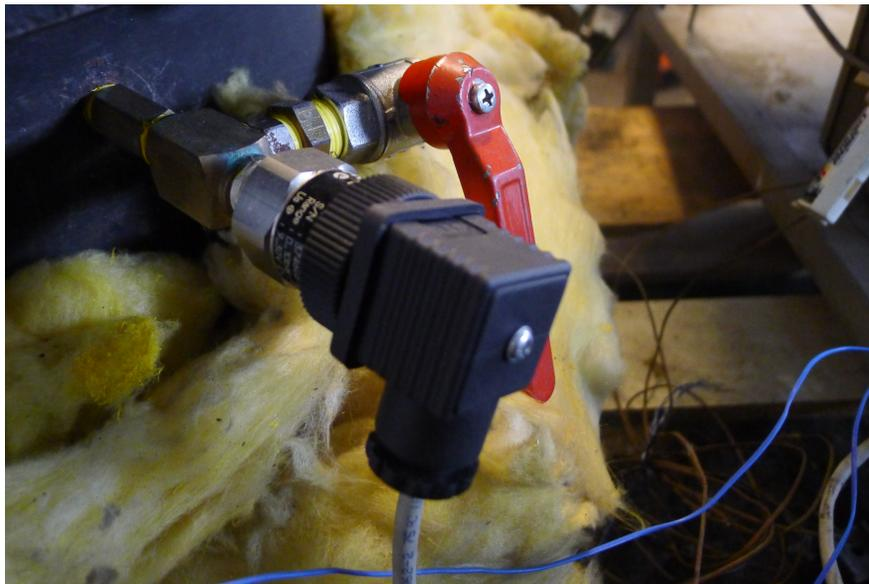
Figura 9.5: Transductor de presión instalado.
