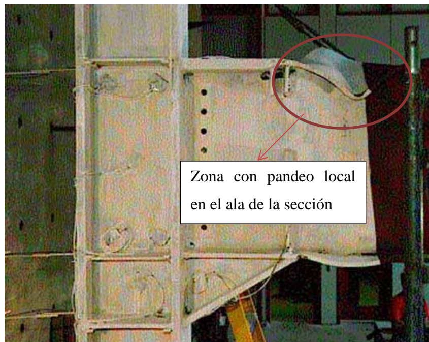
Figura IV.9: Pandeo sección ensayo #19
