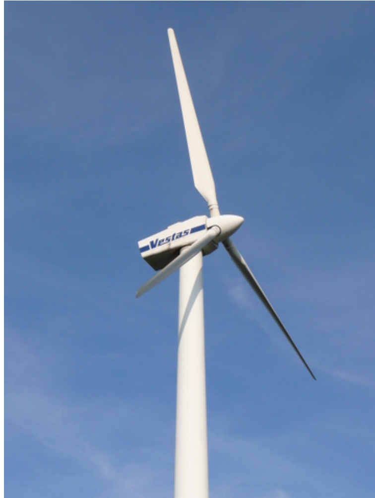
Figura 1.3: Turbina Eólica de Eje Horizontal – Una turbina eólica de eje horizontal en operación. Notar como su eje de rotación en altura implica que el generador eléctrico debe estar en altura, lo cual dificulta altamente la mantención del mismo. Fabricante: Vestas
