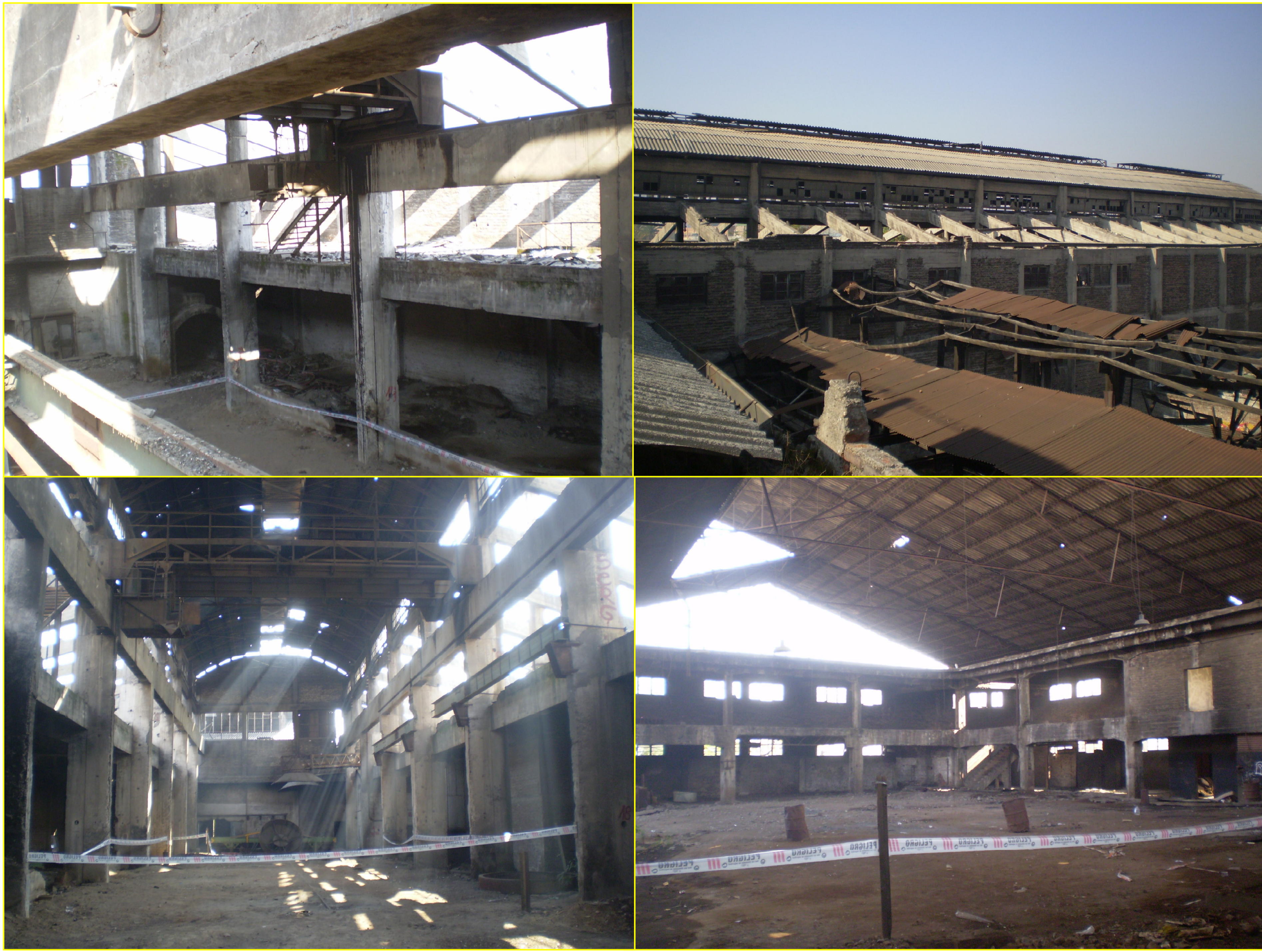
Fotos del estado actual de la Fundación
