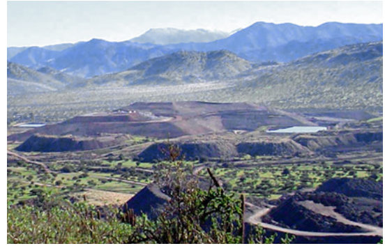
Imagen 1: Relleno Sanitario Loma los Colorados
