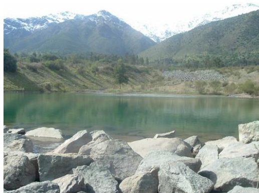
Piscinas decantación llenas en invierno lluvioso. Fuente: internet.
