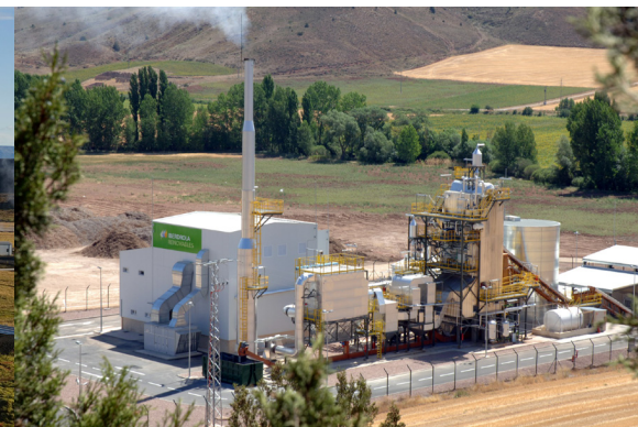
Figura 7. Central Electrica Biomasa Lakeview, EEUU. Fuente: Iberdrola Renovables.
