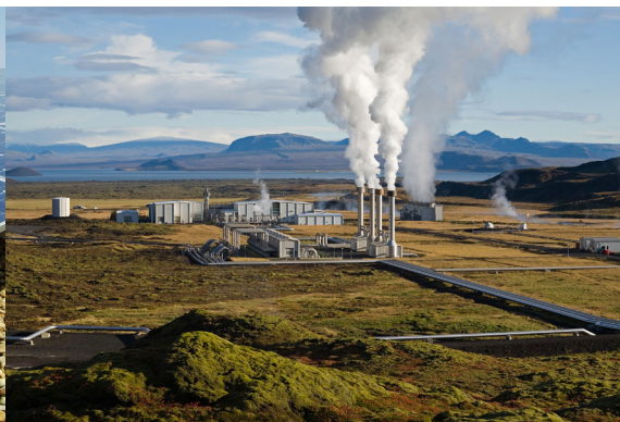
Figura 6. Central Electrica Geotermica de Nesjavellir, Islandia. Fuente: Gretar Ívarsson, Geologista en Nesjavellir.
