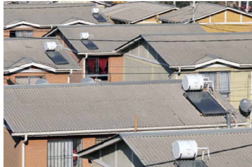
Figura 42. Viviendas sociales con instalación de colectores solares.
