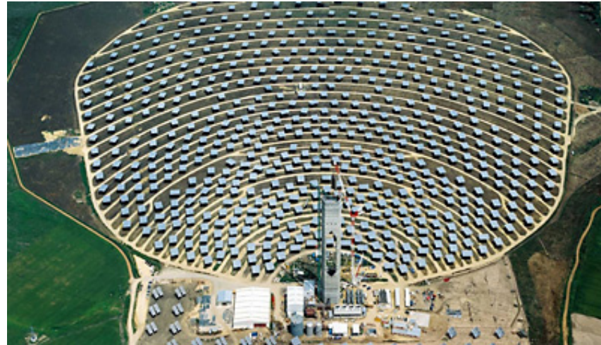
Figura 33. Central Termosolar de Torre, Central PS10, Sevilla.
