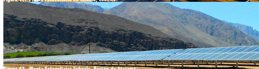
Figura 47. Planta Fotovoltaica Subsole, Región de Atacama.
