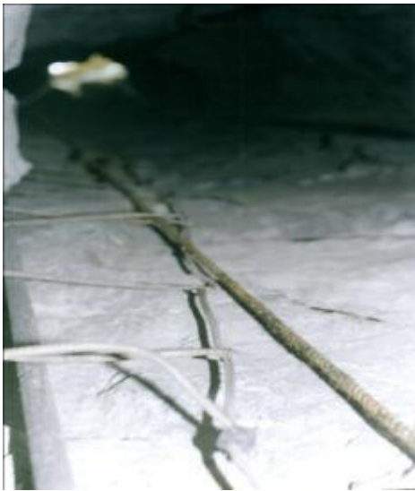
Escalera de cimbra
