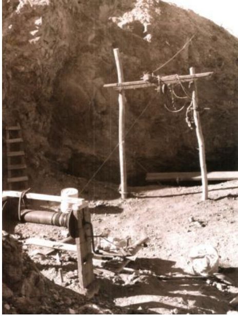
Torno y sistema de polea para izaje
