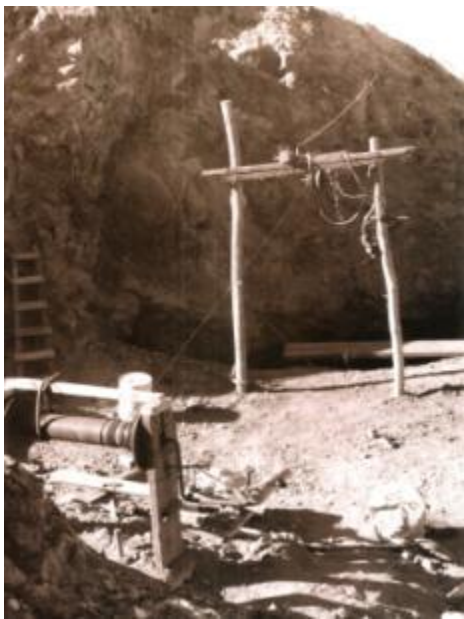
Torno con sistema de izaje
