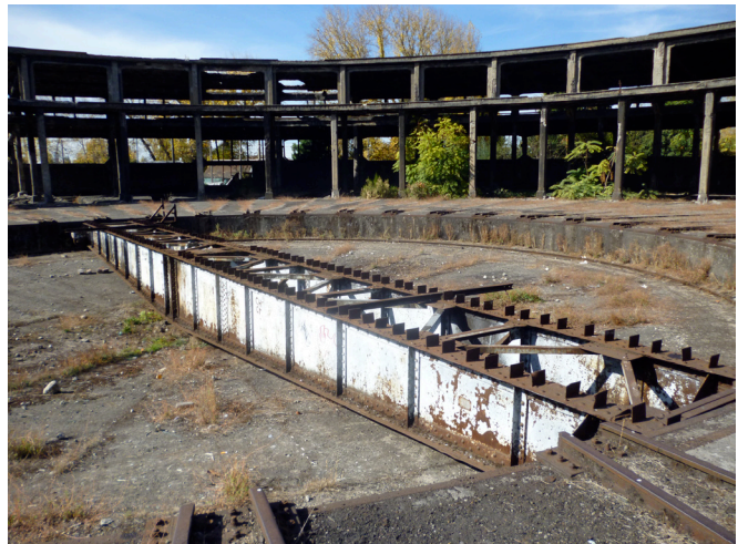
Fig. 81: Casa de Máquinas San Rosendo Fuente: Elaboración propia
