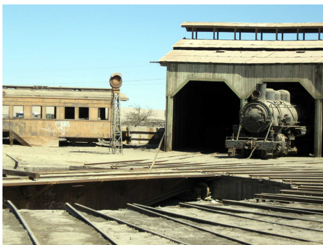
Fig. 8: Casa de Máquinas Baquedano. II Región de Antofagasta.
