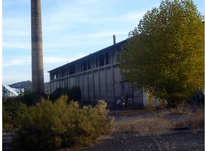
Fig. 101: Chimenea junto a Maestranza Fuente: Elaboración propia
