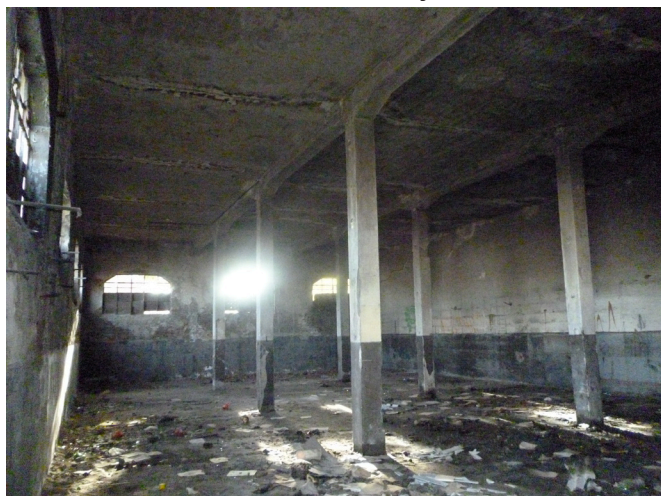
Fig. 106: Interior Oficinas Administrativas Fuente: Elaboración propia
