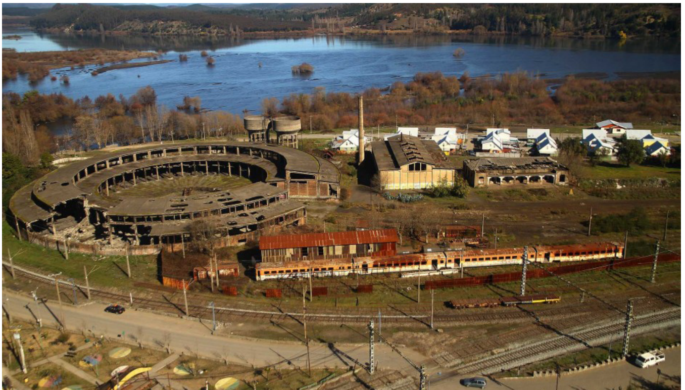
Fig. 2: Vista aérea Conjunto Ferroviario abandonado.
