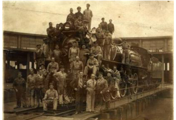
Fig. 21: Trabajadores en la tornamesa de la Casa de Máquinas. [Fuente Imagen: Banco imágenes S.P.S.R.].
