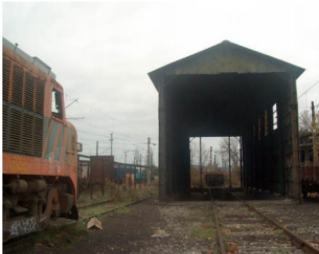
Fig. 111: Galpón de Reparaciones Fuente: Elaboración propia
