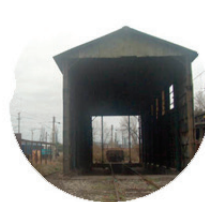
14 - Galpón de Reparaciones
