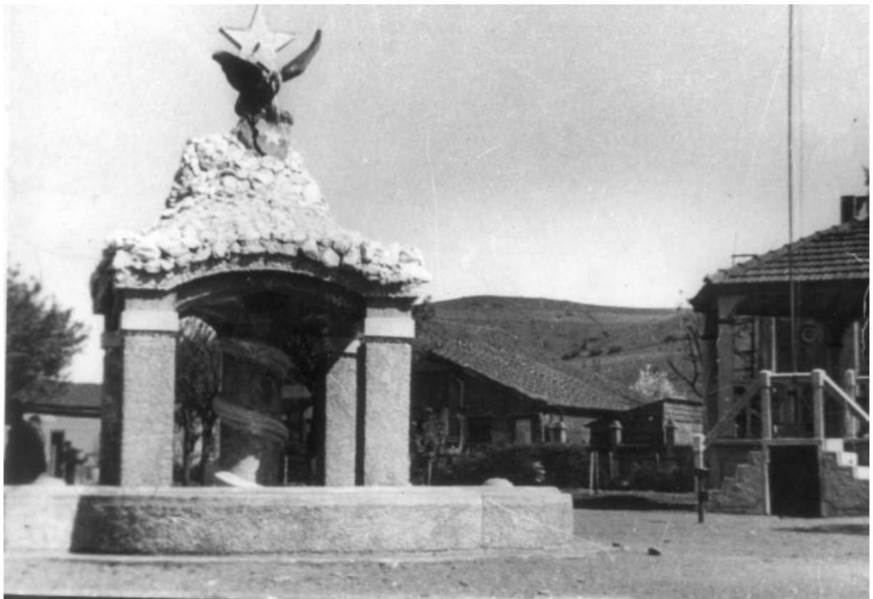
Fig. 26: Antigua Plaza. [Fuente Imagen: Banco imágenes S.P.S.R.].
