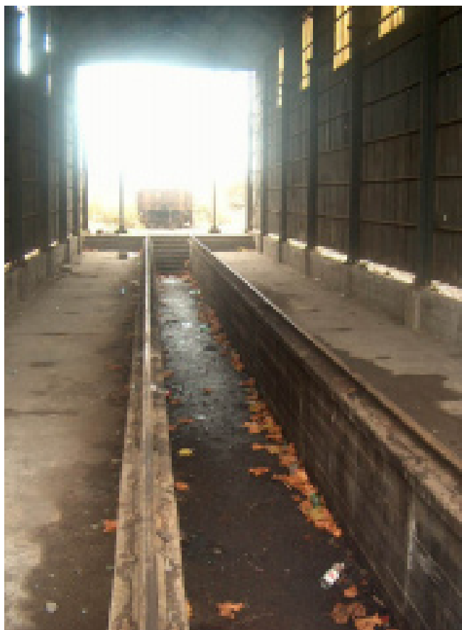
Fig. 112: Galpón de Reparaciones Fuente: Elaboración propia
