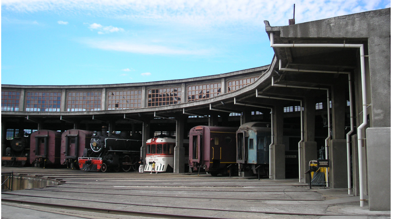
Fig. 5: Casa de Máquinas de Temuco. IX Región de la Araucanía.
