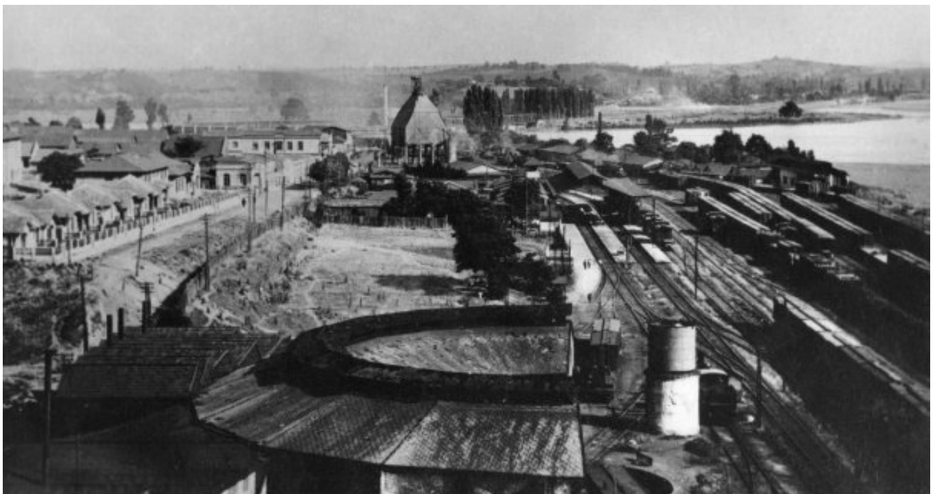
Fig. 17: Casa de Máquinas antigua. [Fuente Imagen: Banco imágenes S.P.S.R.].
