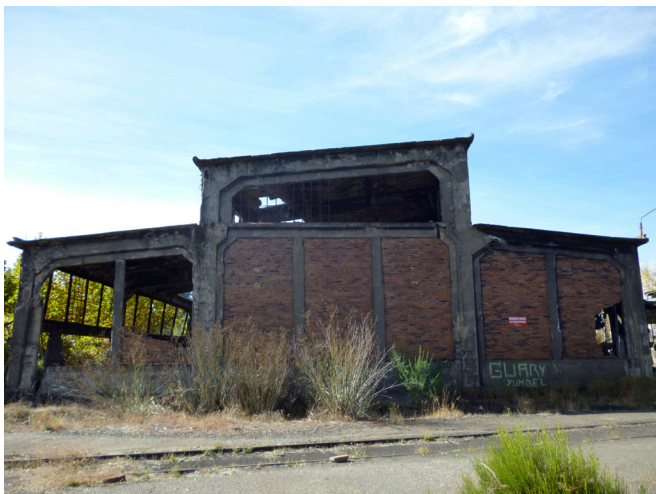
Fig. 28: Casa de Máquinas, año 2012 (Fachada). [Fuente Imagen: Elaboración Propia.]
