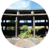
09 - Casa de Máquinas
