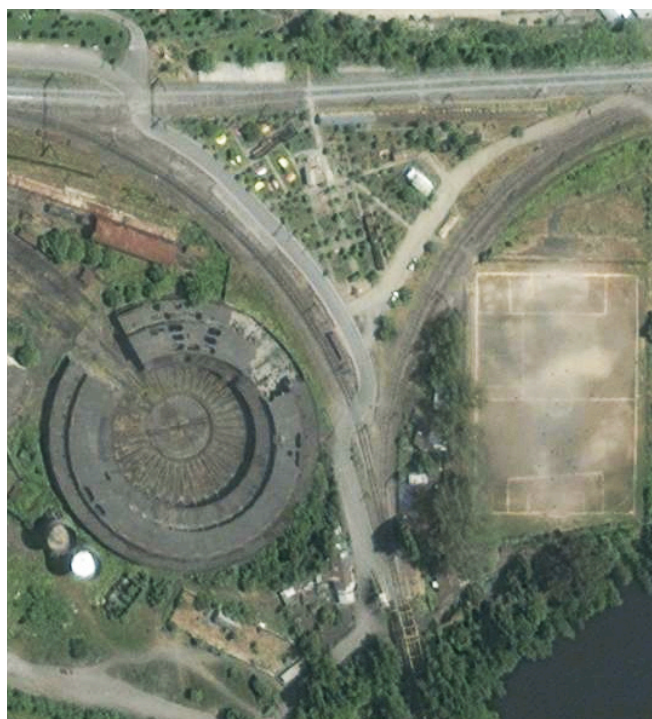
Fig. 68: Casa de Máquinas y Triángulo Ferroviario
