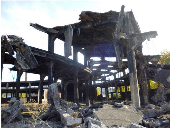
Fig. 89: Casa de Máquinas San Rosendo Fuente: Elaboración propia
