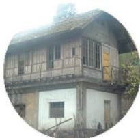
20 - Oficina de Señales
