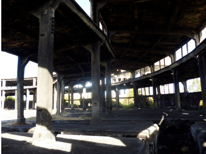
Fig. 88: Casa de Máquinas San Rosendo Fuente: Elaboración propia
