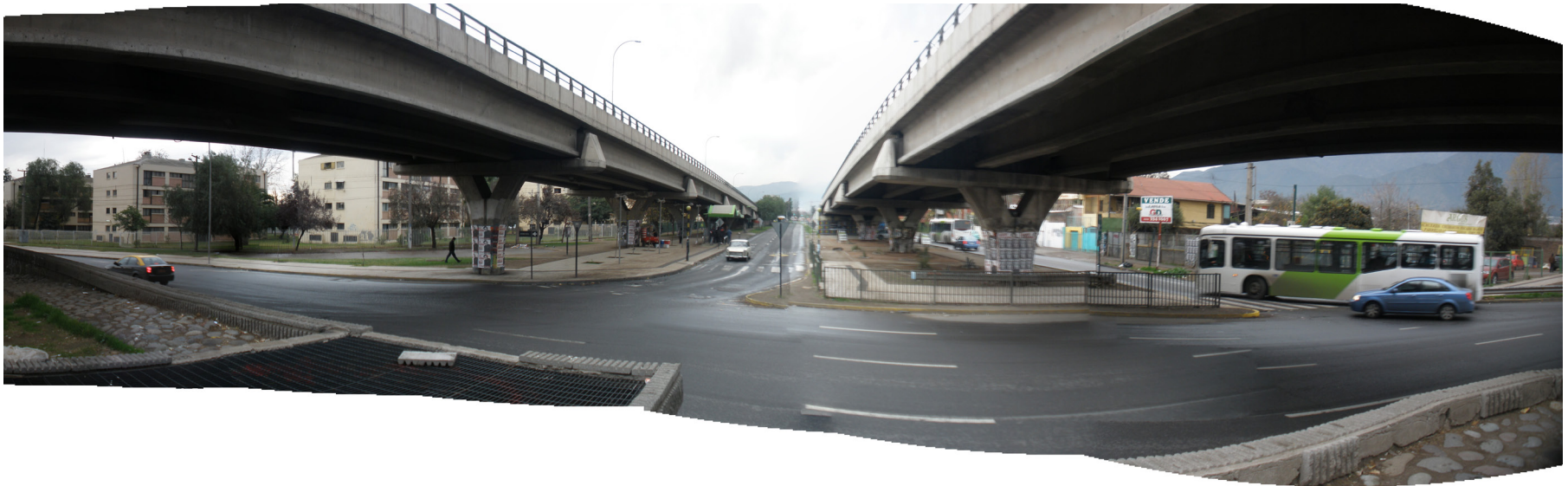
Vista desde sector norte rotonda (espacio intersticial menor) hacia zona norte de Av. Américo Vespucio zona donde comienza la autopista elevada
