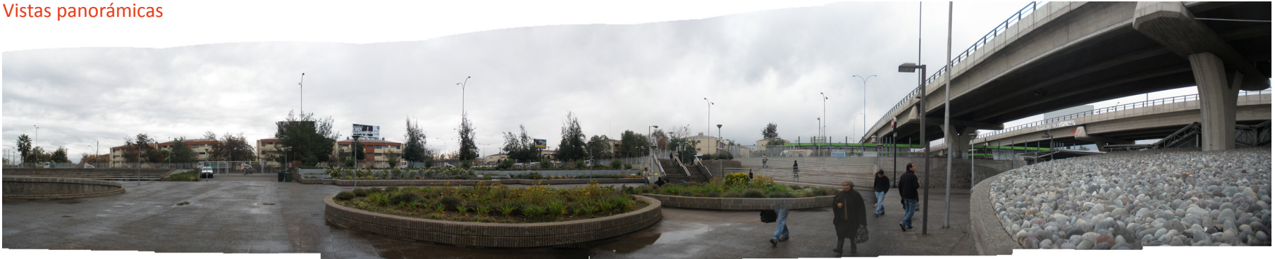
Vista desde interior de rotonda hacia sector de paraderos transantiago (Av. Grecia).
