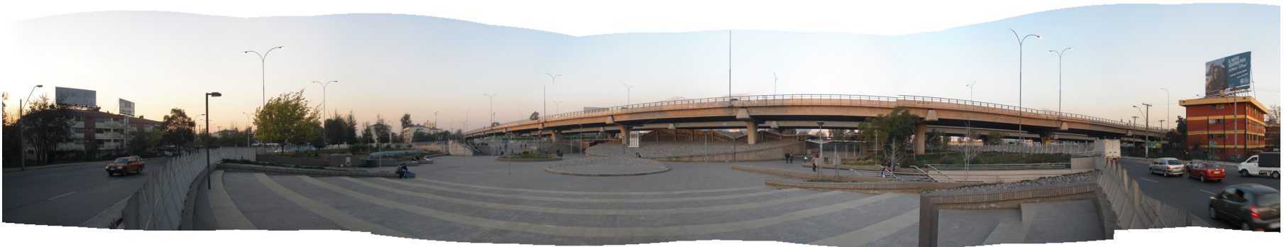
Vista desde límite interior de rotonda sector de Rodrigo de Araya hacia salida del metro estación Grecia. Zona de mayor explanada en términos de superficie.
