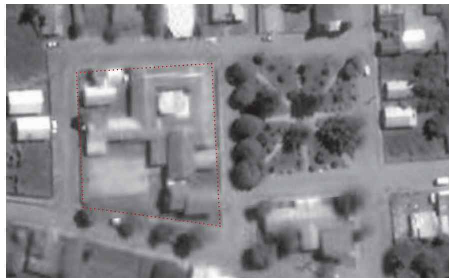
Emplazamiento Fuente: Google Earth
