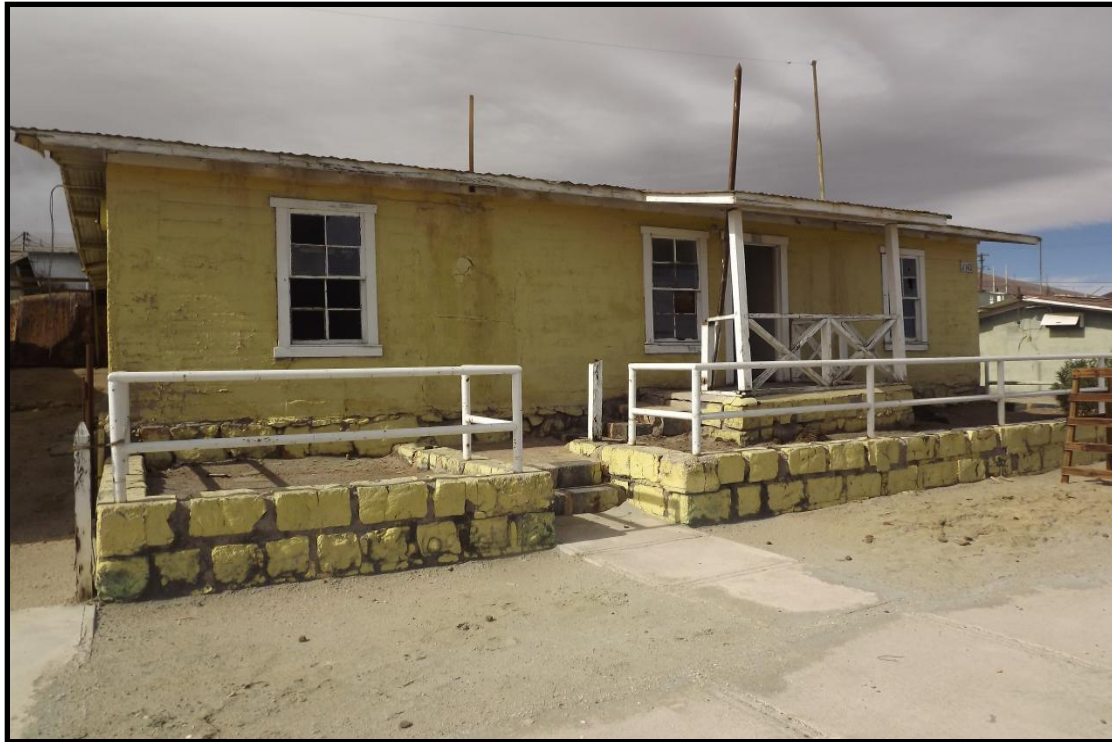
Vivienda tipo del sector 'Dublé'. Fotografía obtenida de la visita a terreno, julio de 2012.
