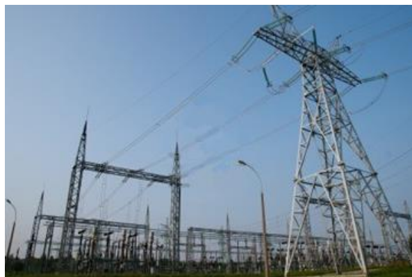
Figura 2.3 Torre de remate
