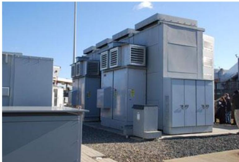
**Figura 3.6 Sistema de baterías o BESS**
