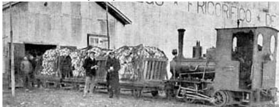
Figura 71: Frigorífico Puerto Bories en Funcionamiento
