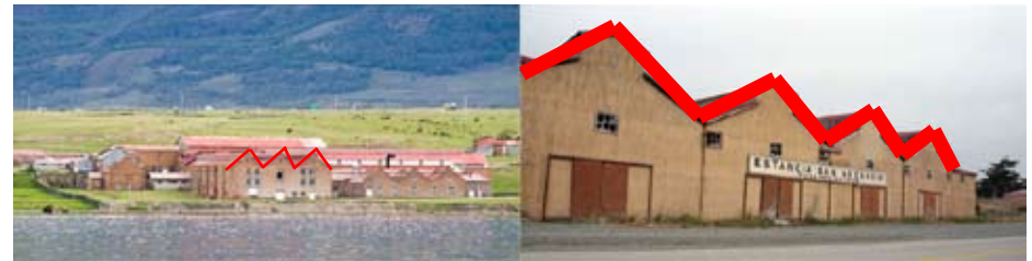
Figura 110: Arquitectura Industrial Local
