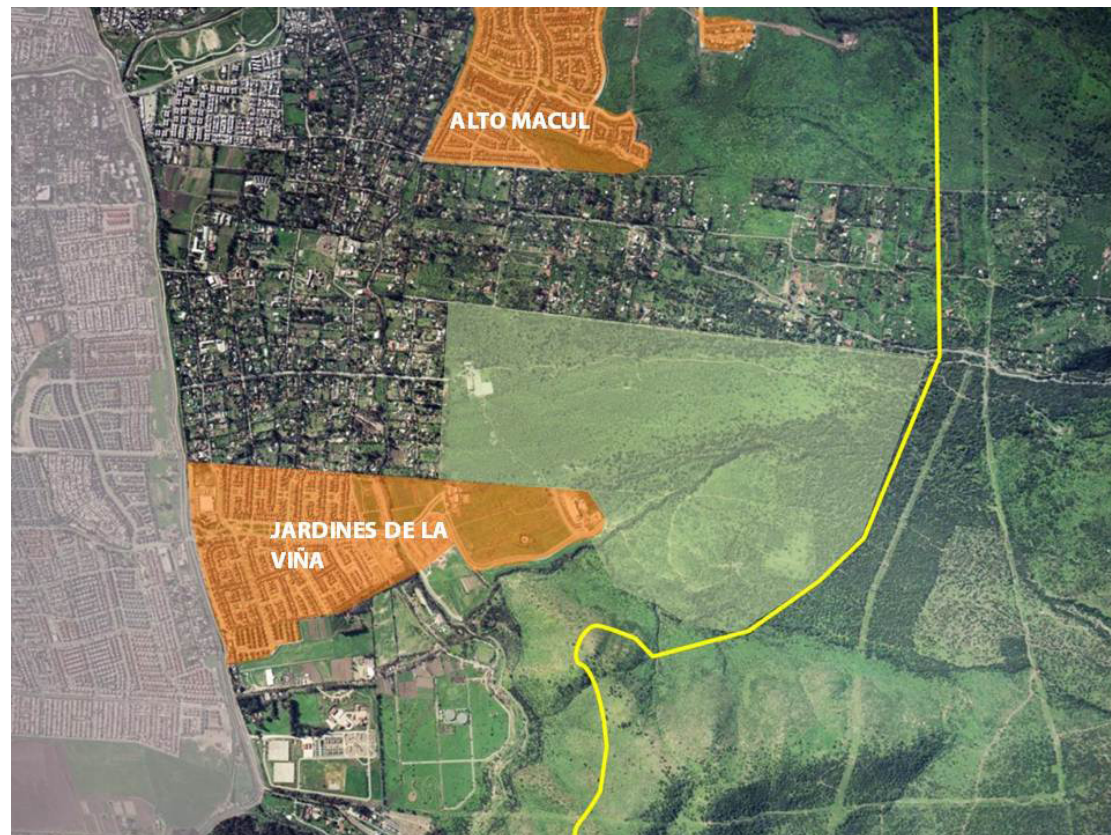
EN LOS ÚLTIMOS AÑOS SE HAN IDO CONSTRUYENDO ESTOS PROYECTOS DE CONJUNTOS HABITACIONALES Y DE NO CAMBIAR LA NORMATIVA VIGENTE, EL BOSQUE PANUL PODRÍA CONVERTIRSE EN OTRO DE ELLOS.
