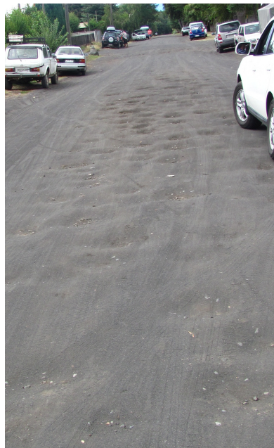
Figura 1.1: Camino en el sur de Chile luego de una intensa lluvia, se observan agujeros de un tamaño bien definido en todo el camino.
