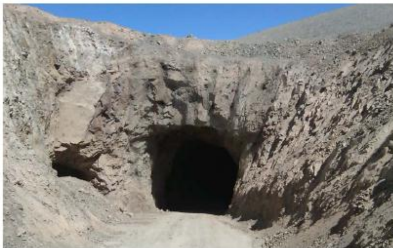
Figura 9: Portal Nicolasa Nivel 1250 con acuñadura y enmallado
