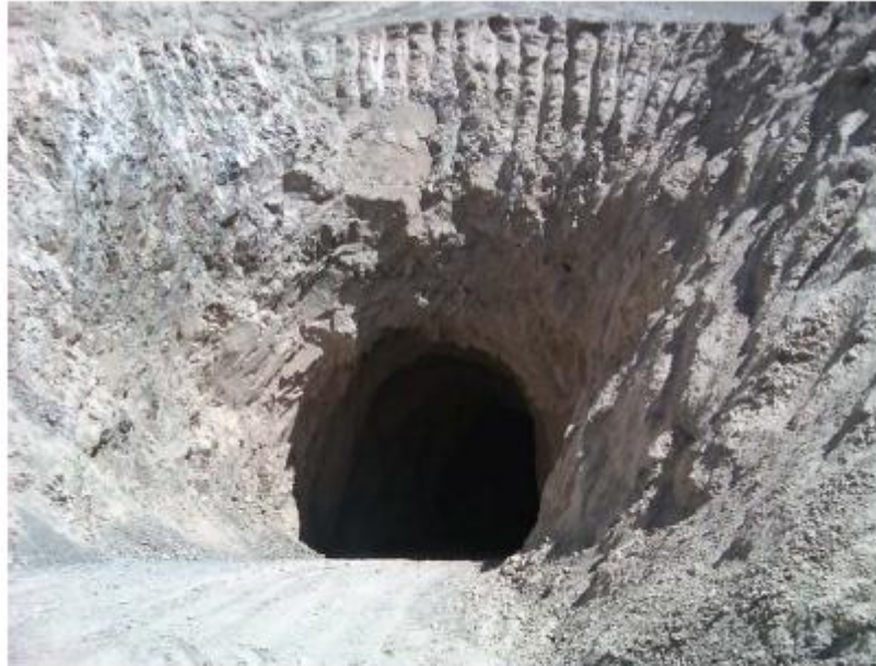
Figura 10: Portal Yammal Nivel 1210 con acuñadura
