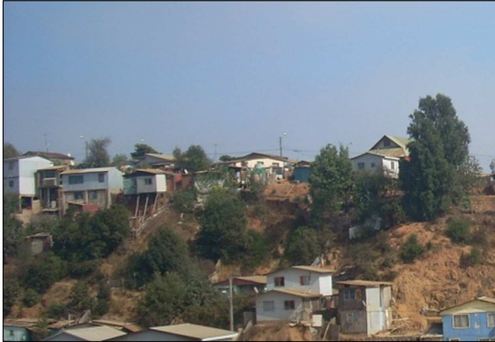
Fotografía 3.1. Ejemplo de autoconstrucciones en zonas con fuertes pendientes. Fuente: Obtención propia. Fotografía del sector Forestal (Las Palmas, Viña del Mar)
