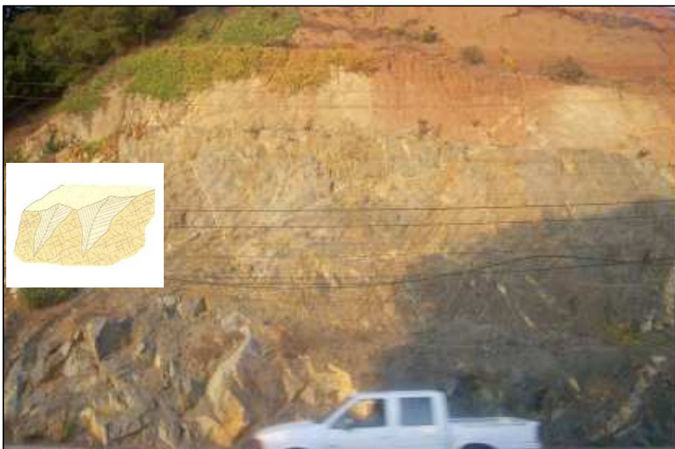
Figura 6.3. Registros de eventos de tipo deslizamiento de cuñas en camino costero sector Reñaca. – Las Salinas. Fuente: Obtención y elaboración propia
