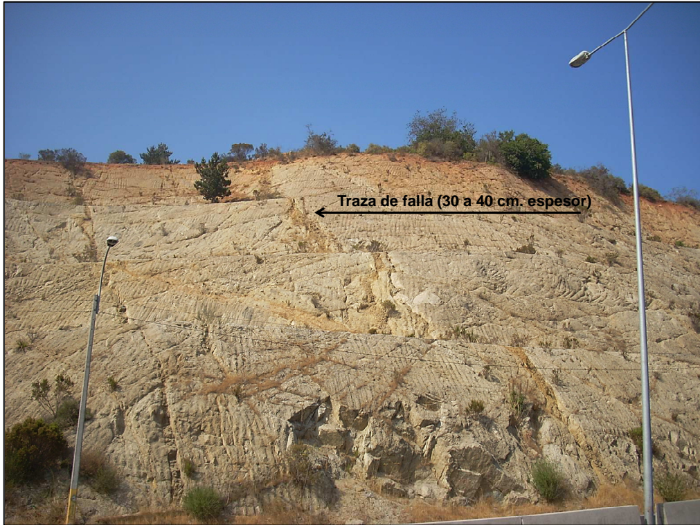
Fotografía 7.1. Talud ruta Las Palmas en dirección a Viña del Mar donde se reconoce falla que correspondería a la traza mapeada por Gana et al. (1996) asociada a la falla Marga-Marga. Fuente: Obtención propia
