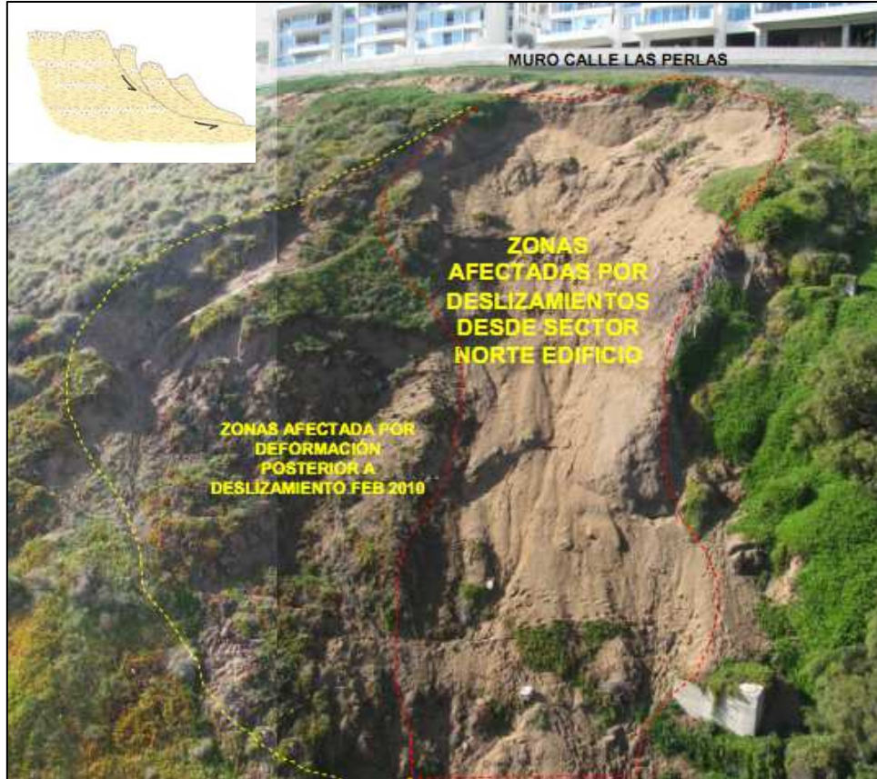
Figura 6.4. Registros de eventos de tipo deslizamiento rotacional sector Reñaca Cochoa en arenas de dunas Fuente: Obtención y elaboración propia
