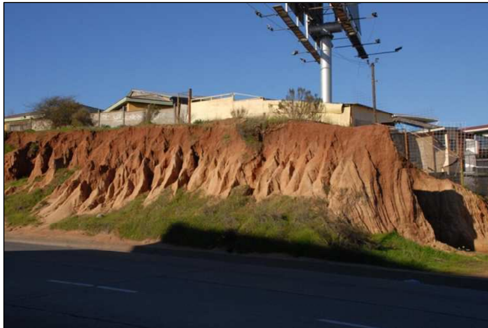
Fotografía 5.8. Evidencia de procesos erosivos y de meteorización (cárcavas) presentes en paleodunas
