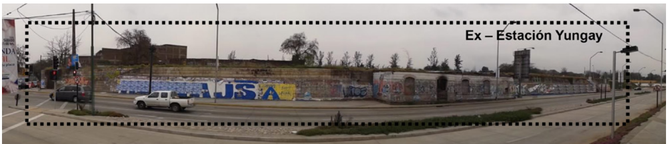
Fig 52. Fotografía Ex Estación Yungay. 2012.
