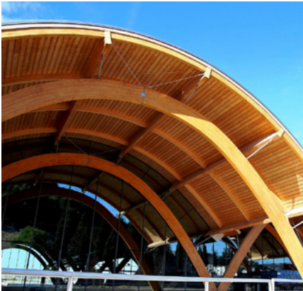
Fig. 83. Cubierta de las bodegas Protos, en Peñafiel (Valladolid), de Richard Rogers
