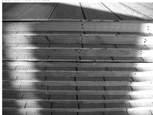
fig95 _ Vigas 2T, alma OSB fuente: Ingepanel
