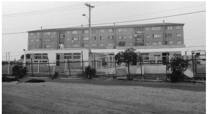
fig48 _ Escuela básica en construcción, cercana a la Parcela 11 elab. propia
