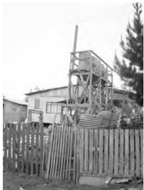
fig42 _ Torre de agua de una vivienda fuente: Al Margen de la Ciudad
